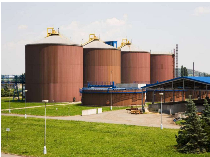
Obr. 14 Vyhnívací nádrže na provozu ČOV [74].
