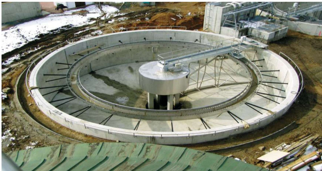
Obr. 7 Pohled na konstrukci usazovací nádrže [59].
