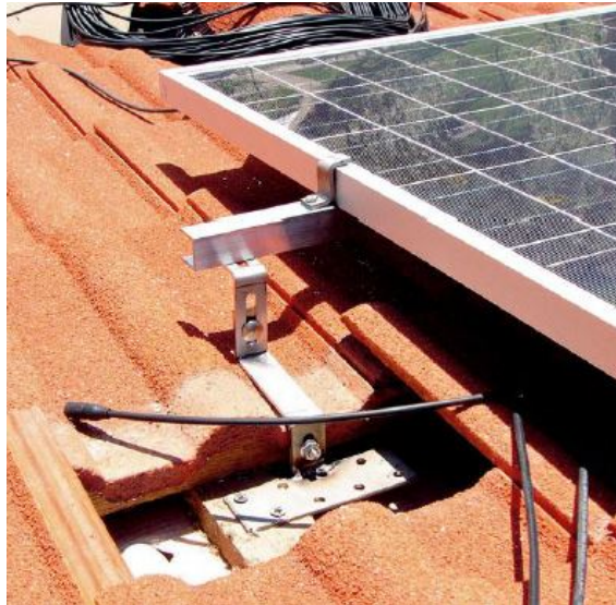
Obr. 1.12: Konstrukce upevnění pro šikmé střechy. [17]
