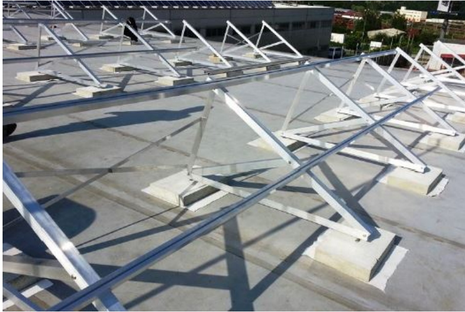
Obr. 1.13: Konstrukce pro ploché střechy. [17]
