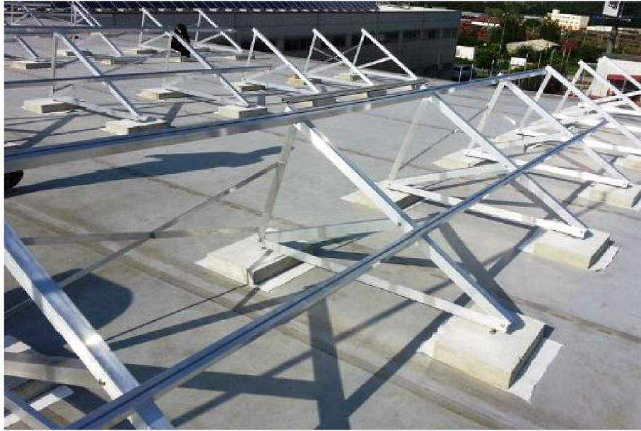
Obr. 1.13: Konstrukce pro ploché střechy. [17]
