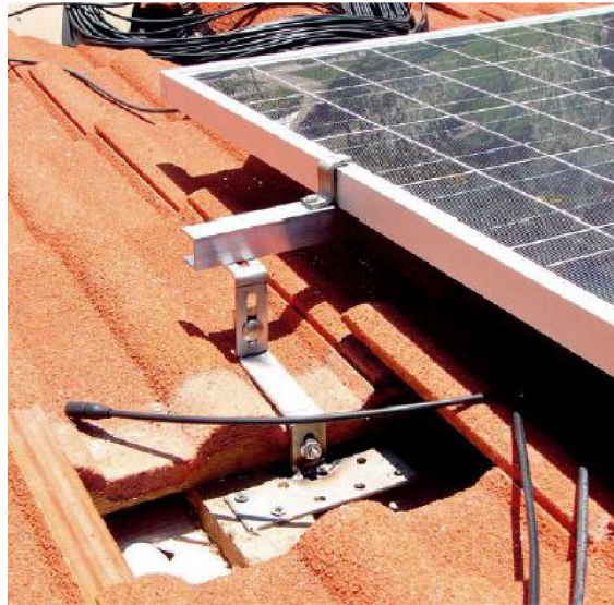
Obr. 1.12: Konstrukce upevnění pro šikmé střechy. [17]
