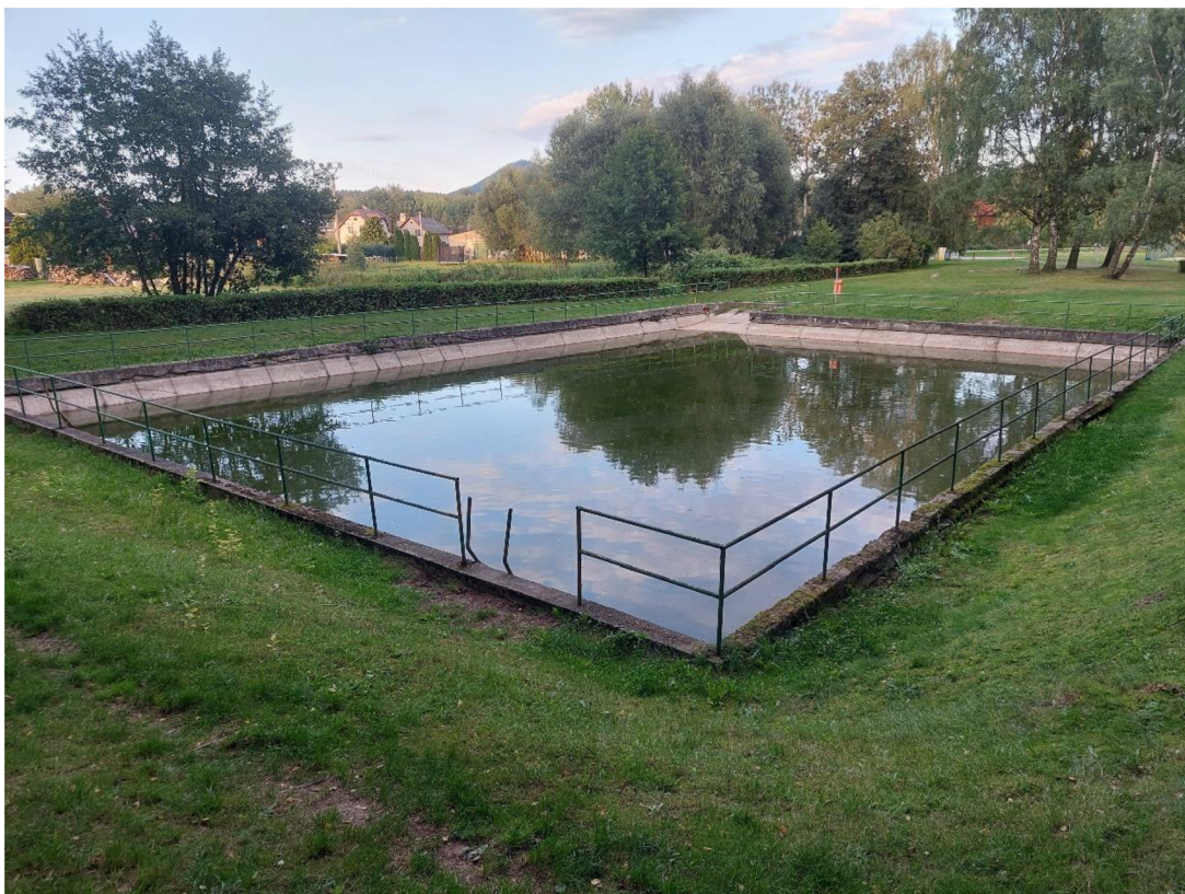
Obrázek 5 Požární nádrž v obci Okna v roce 2022 (vlastní fotografie)
