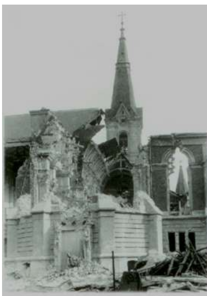
Obr. 10: Demolice kostela sv. Jindřicha (Hajzlerová 2002).
