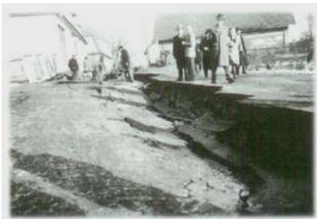
Obr. 9: Propadlá část silnice – vliv poddolování (Hajzlerová 2002).
