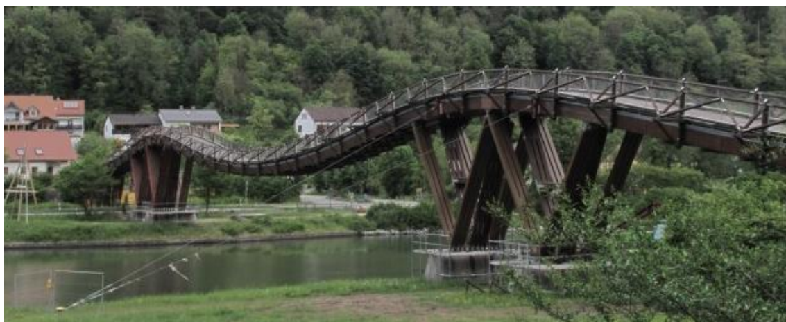
Obr. 1.5 Lávka přes kanál Main – Donau [27]
