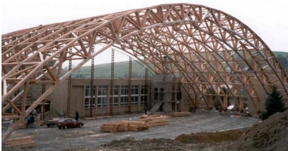
Obr. 4.1 Konstrukce zastřešení během výstavby [14]
