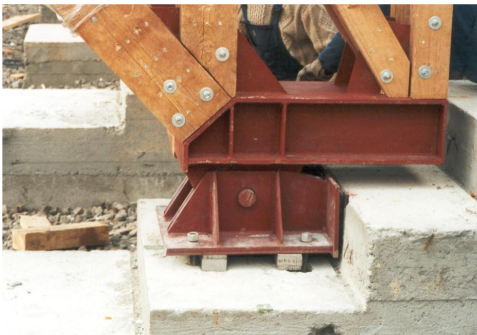
Obr. 4.5 Kloubové ložisko na základové patce [14]
