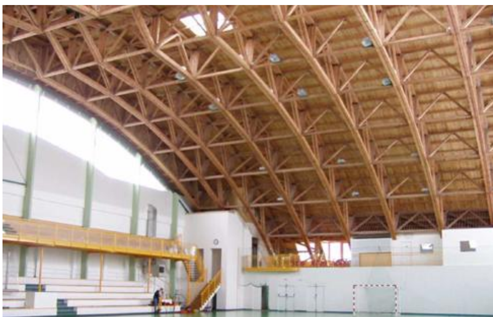
Obr. 4.2 Vnitřní pohled na střešní konstrukci [14]
