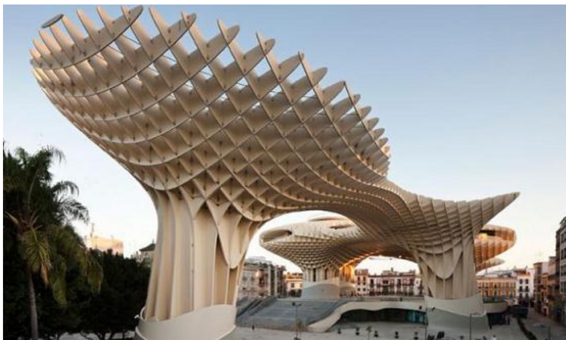
Obr. 1.2 Metropol Parasol v Seville – pohled zespodu [32]
