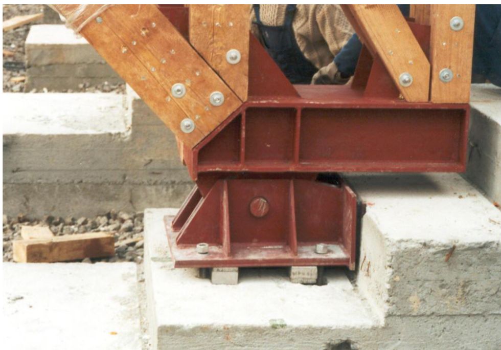
Obr. 4.5 Kloubové ložisko na základové patce [14]
