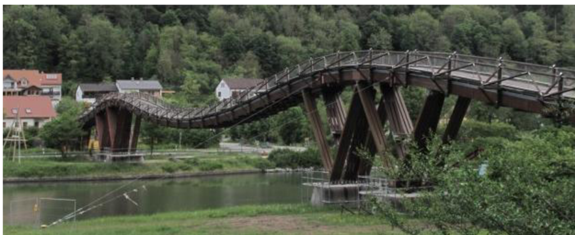
Obr. 1.5 Lávka přes kanál Main – Donau [27]
