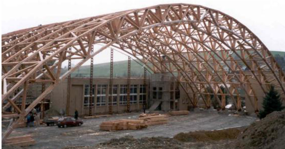
Obr. 4.1 Konstrukce zastřešení během výstavby [14]
