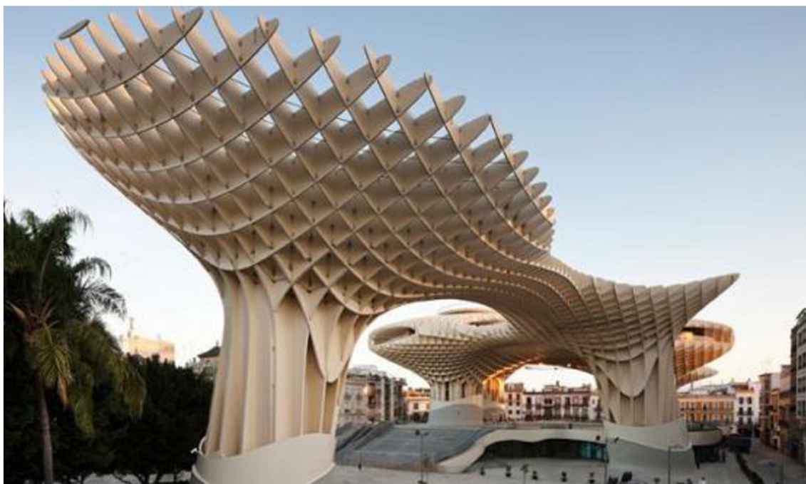
Obr. 1.2 Metropol Parasol v Seville – pohled zespodu [32]
