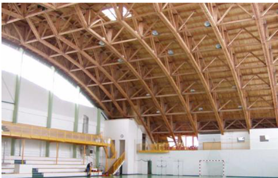
Obr. 4.2 Vnitřní pohled na střešní konstrukci [14]
