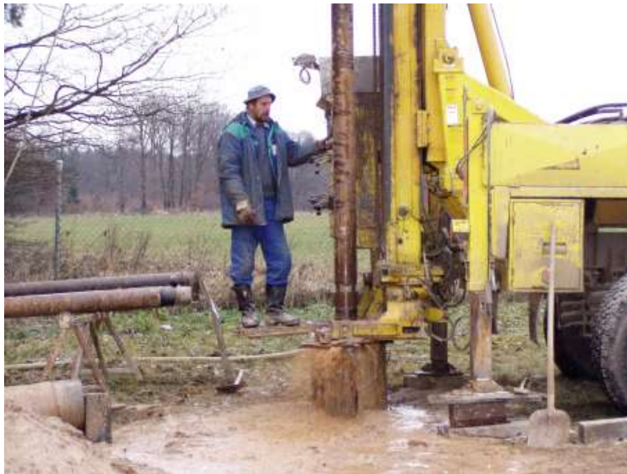
Foto č. 3: Vrtné práce, moment kdy se narazilo na podzemní vodu (vrt S3)
