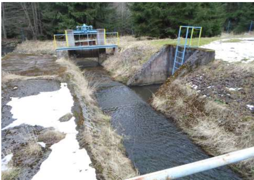
Foto č. 11: Ochranné pásmo a odběrné místo na Klabavě, stavidlo pro regulaci při menších průtocích
