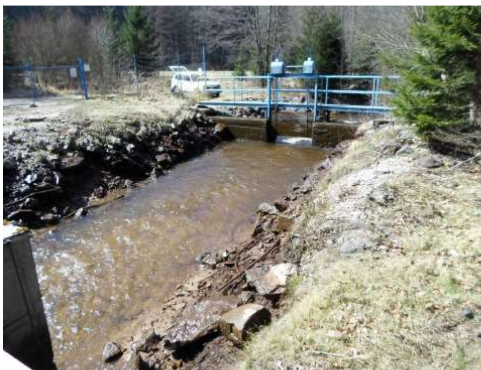
Foto č. 10: Otevření stavidla k zajištění minimálního vzdutí pro vyčištění jímacího objektu a sacího koše
