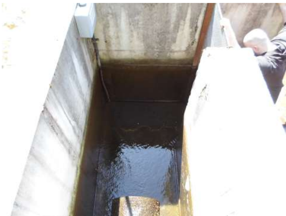
Foto č. 9: Čištění sacího koše při minimálním vzdutí Třítrubeckého potoka
