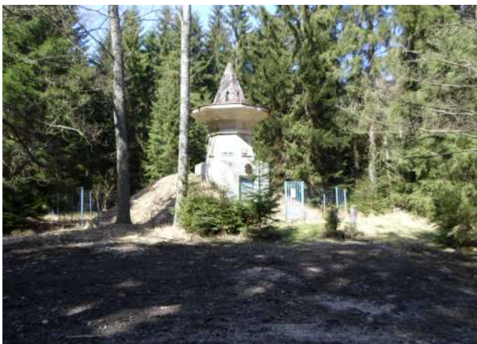
Foto č. 18: Vodárenský objekt „U Rybiček“ sloužící jako spojná komora
