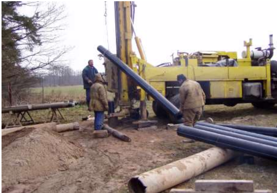
Foto č. 5: Napojování trub se závitovými spoji (vrt S3)
