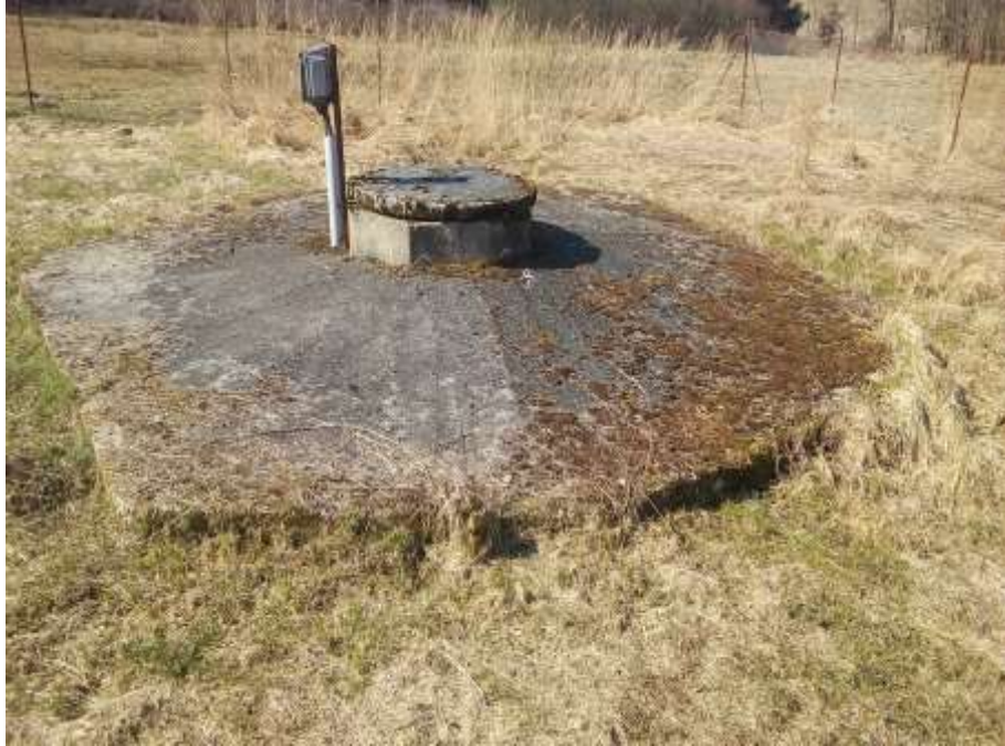
Foto č. 1: Vrt opatřený ochrannou betonovou deskou, prameniště 1
