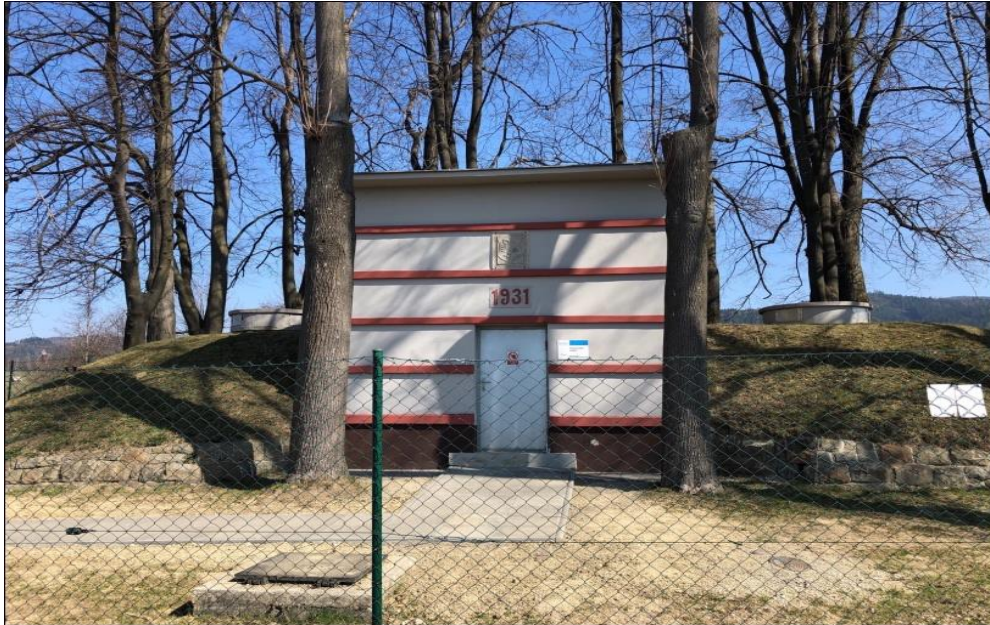
Obrázek 6 Přerušovací vodojem Alžbětinky 2x100 m 3 , město Jablunkov (Zdroj: vlastní foto)
