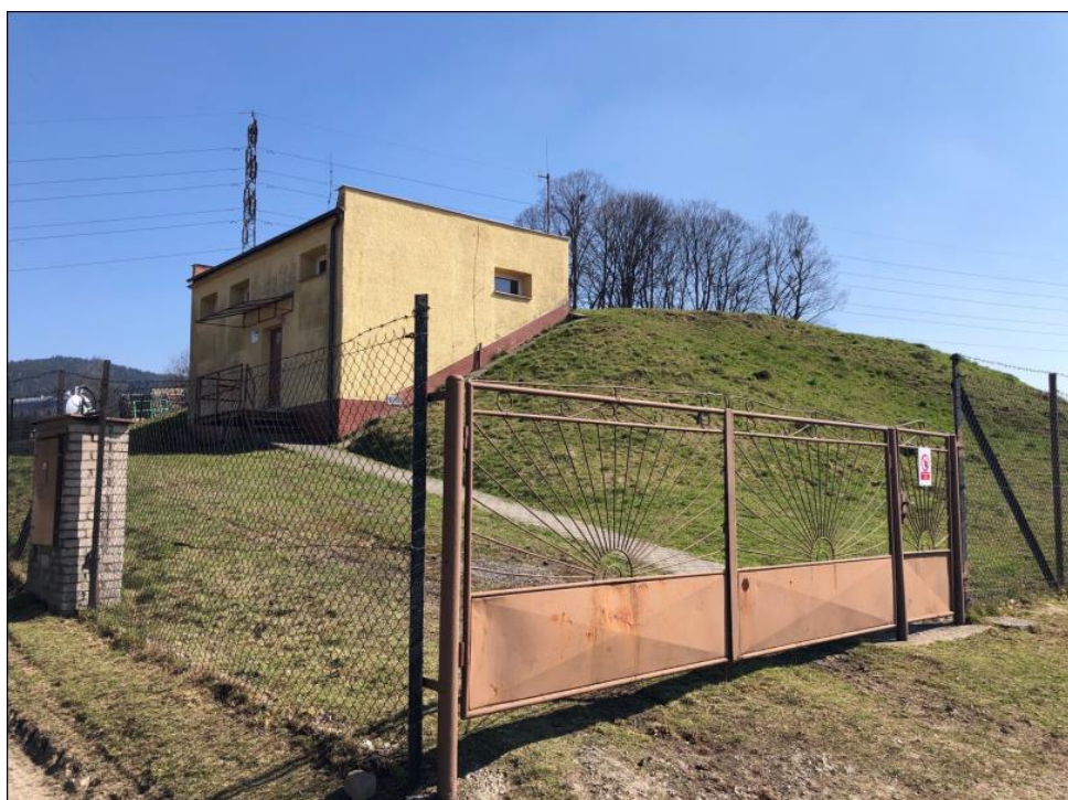
Obrázek 5 Vodojem Alžbětky 1000 m 3 , město Jablunkov (Zdroj: vlastní foto)
