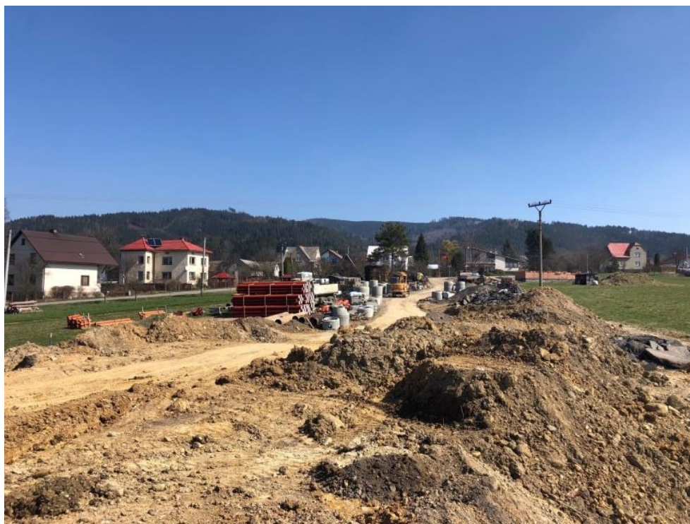
Obrázek 8 Aktuálně probíhající stavba kanalizace, obec Písečná (Zdroj: vlastní foto)
