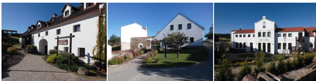
Obr. 14: Svachův Dvůr (zleva), Tee House (uprostřed) a Destilérka Svach (zprava)
