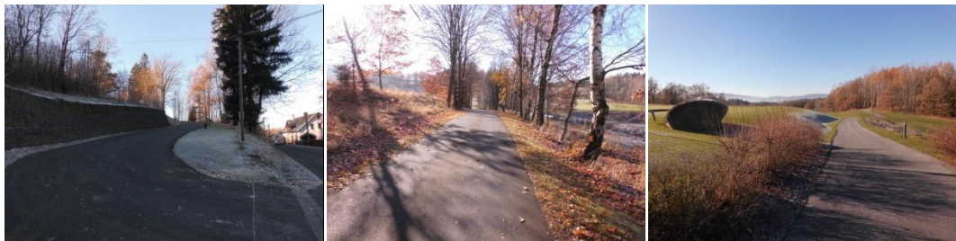
Obr. 19: Zrekonstruovaná příjezdová cesta a komunikace vedoucí skrz GH Ypsilon Golf Liberec
