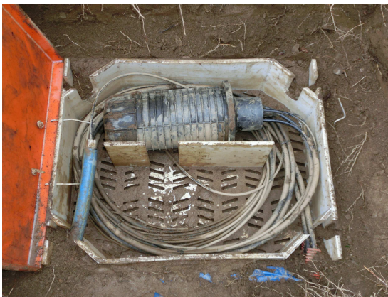
Obr. 8.22 Spojka s kabelovou rezervou
