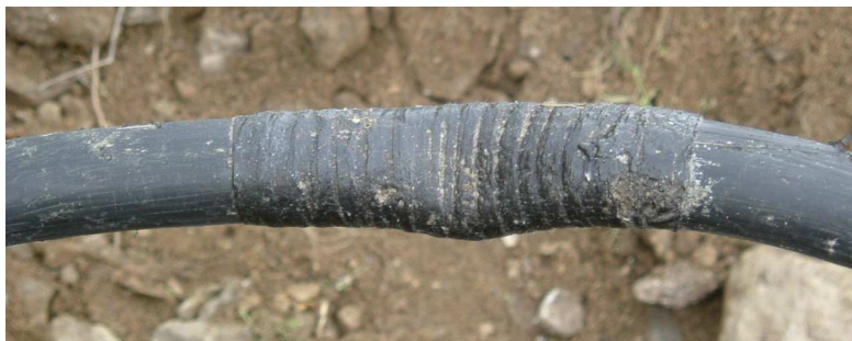
Obr. 8.27 Laicky opravený kabel
