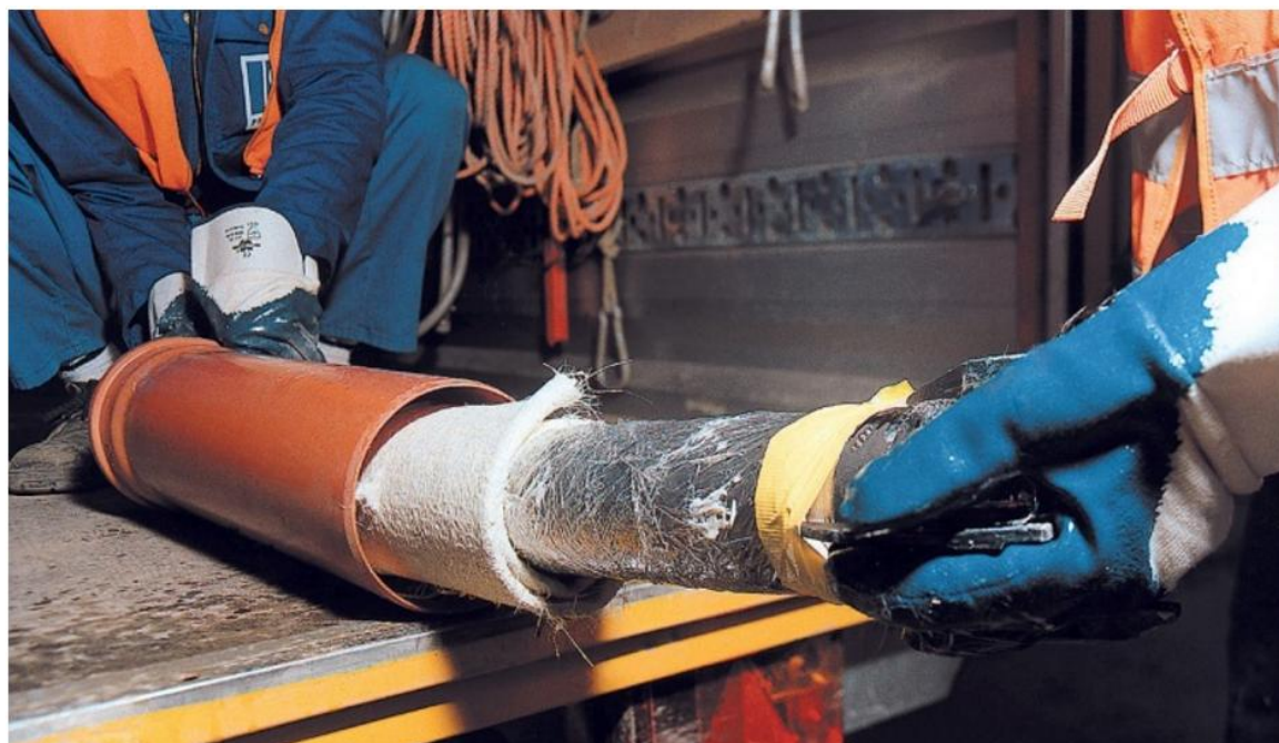
Obr. 16 Short liner záplata [29]
