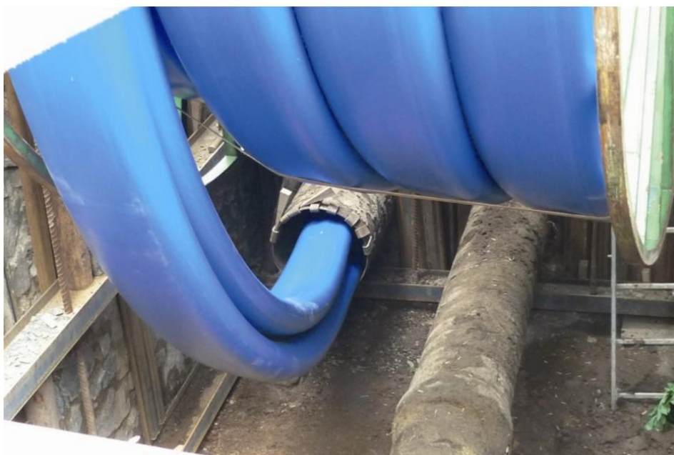
Obr. 27 Ukázka zatahování trubky „C-profilu“ do stávajícího profilu [43]
