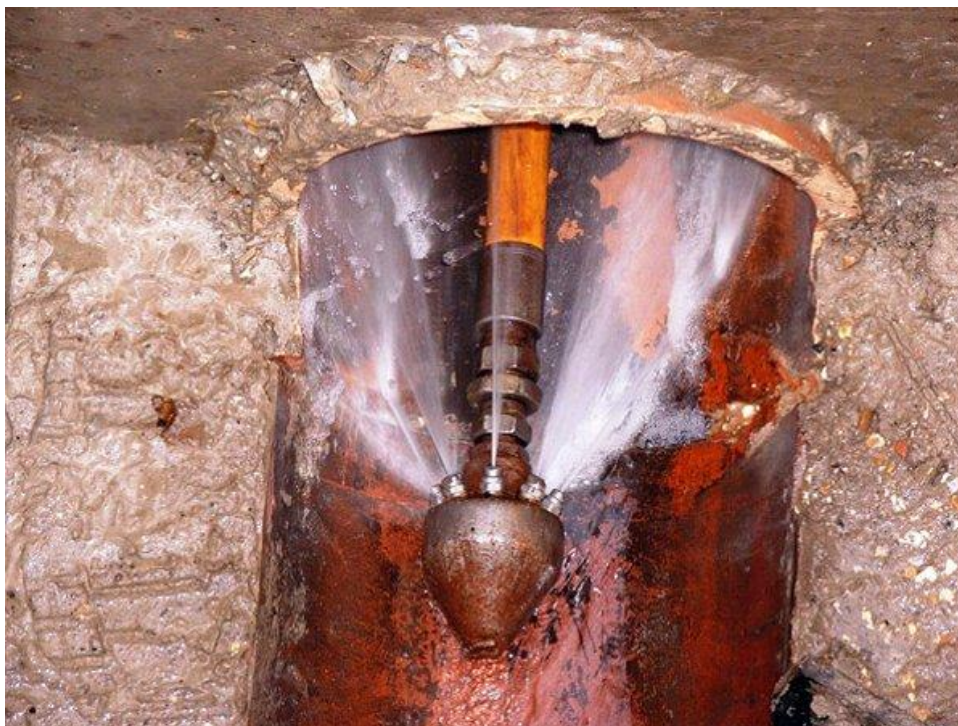
Obr. 11 Vysokotlaké čištění vodou [20]
