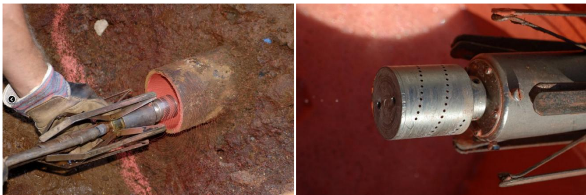
Obr. 24 Vysokorychlostní rotující tryska aplikující epoxidovou pryskyřici [39]
