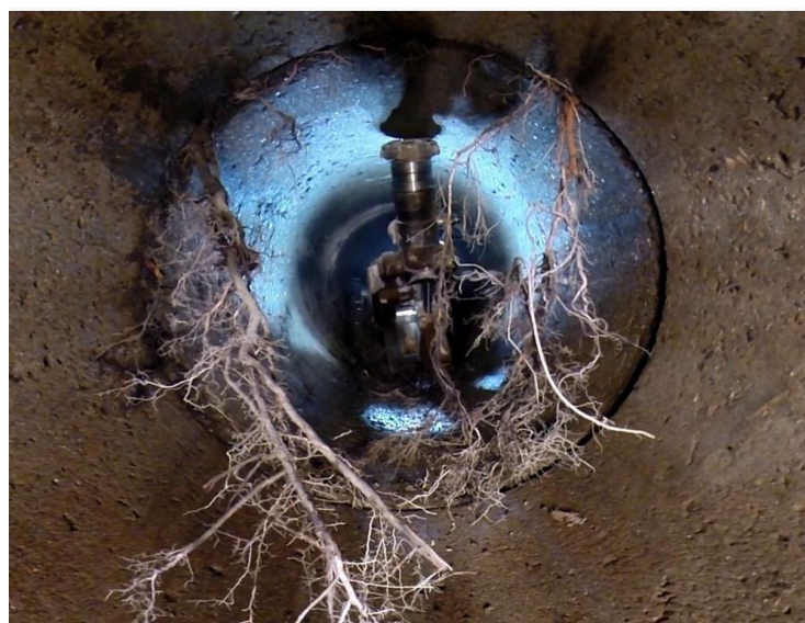
Obr. 4 Prorůstání kořenů do kanalizace[5]
