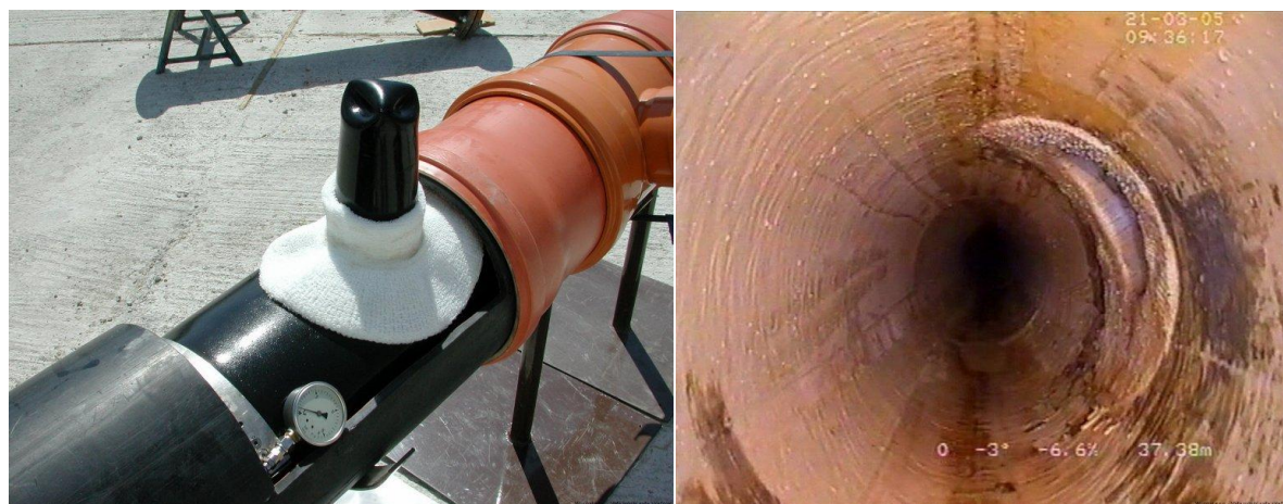
Obr. 19 Metoda Klobouk vnější pohled (vlevo), vnitřní pohled z robokamery (vpravo)[32]
