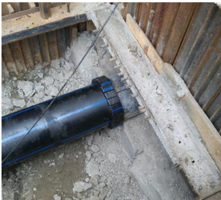
Obr. 31 Sanace potrubí metodou Swageling v Praze Dejvicích firmou ZEPRIS s.r.o. - doraz
