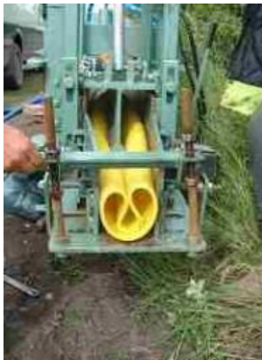
Obr. 26 Ohýbání za studena na místě [41]
