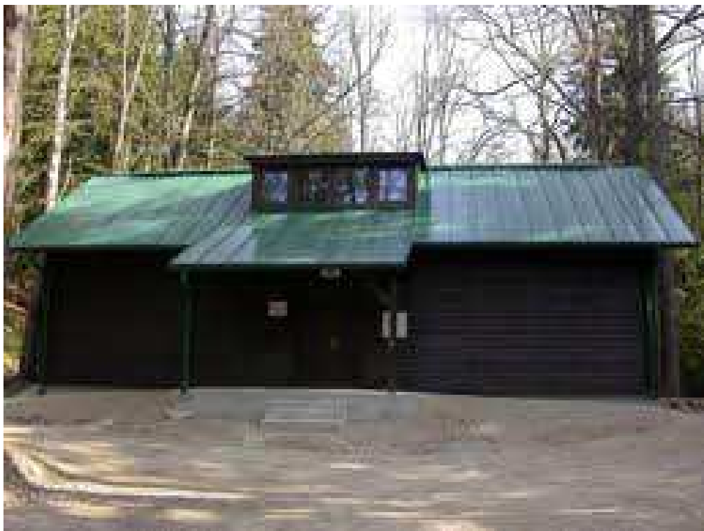
Obr. 3.11 Úpravna vody Limnice [33]
