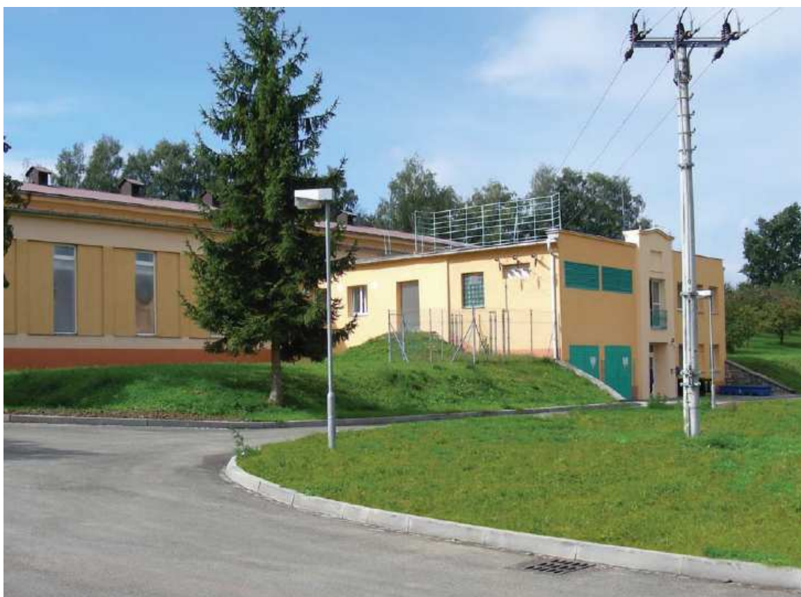
Obr. 3.12 Úpravna vody Kněžpole [36]
