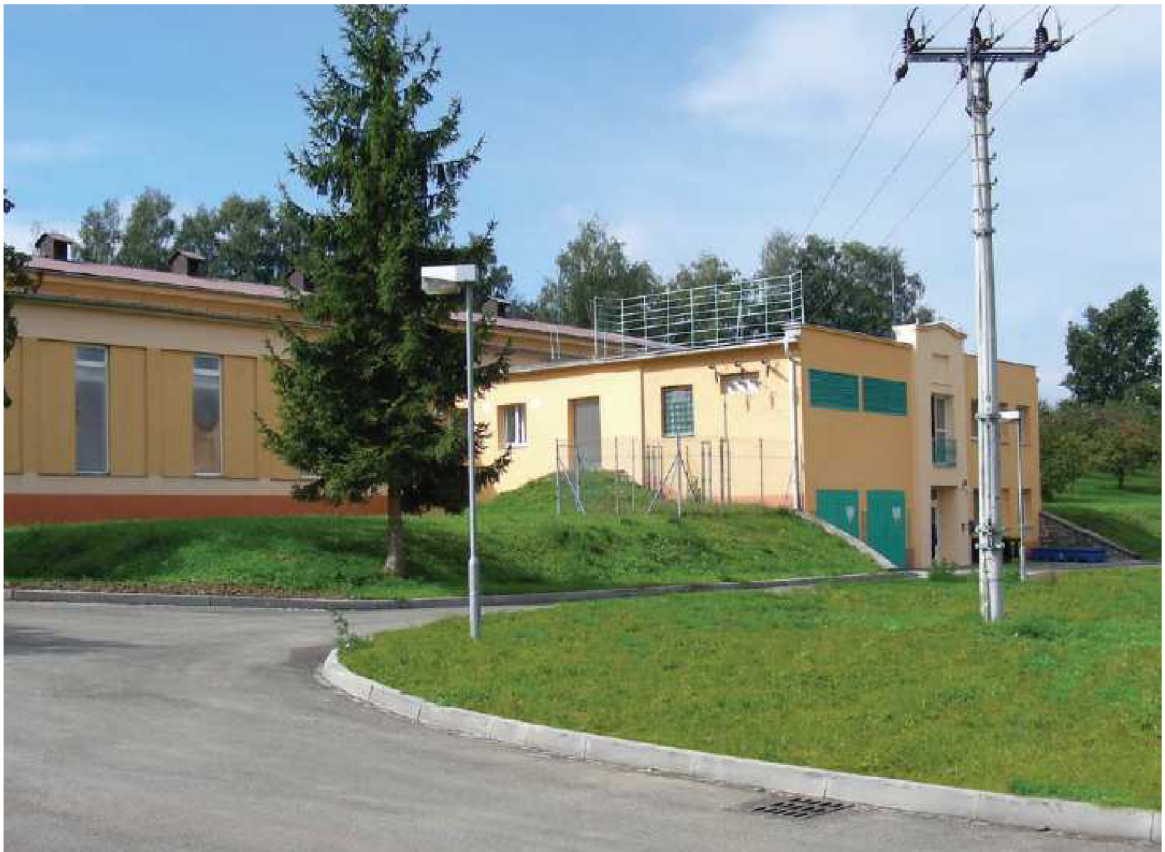
Obr. 3.12 Úpravna vody Kněžpole [36]
