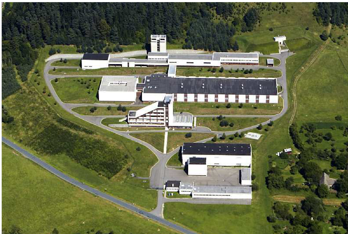
Obr. 3.13 Úpravna vody Švařec [38]
