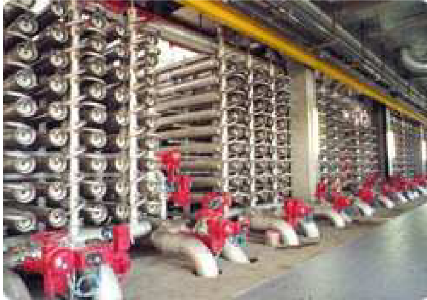
Obr. 3.7 Nanofiltrační jednotky na ÚV Méry sur Oise [25]
