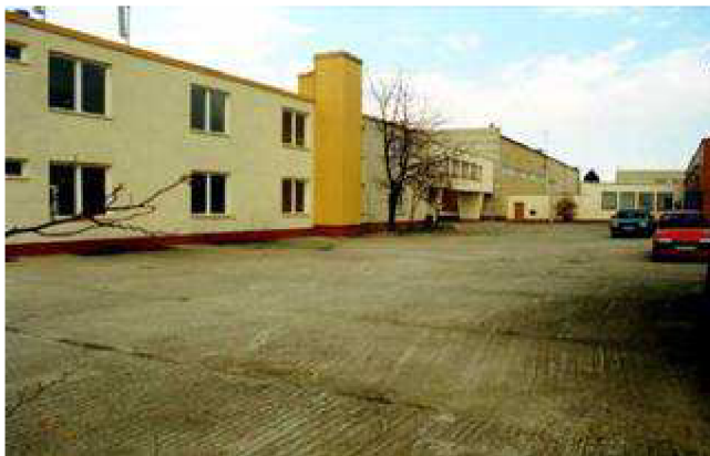
Obr. 3.3 Pohled na ÚV Ostrožská nová ves [43]
