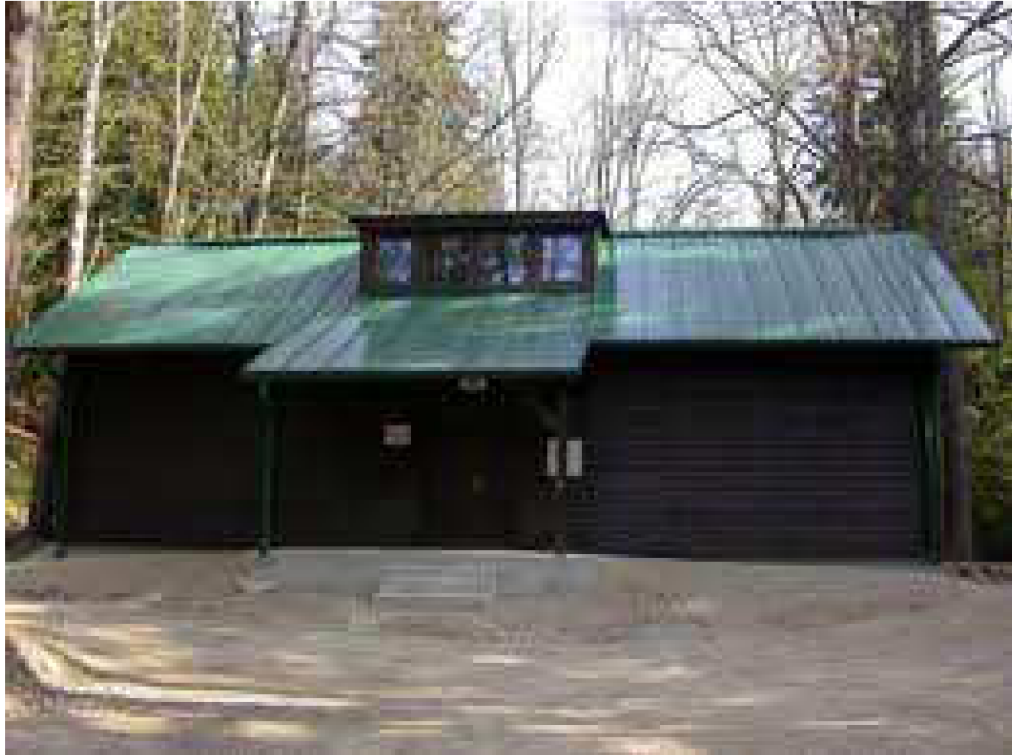
Obr. 3.11 Úpravna vody Limnice [33]
