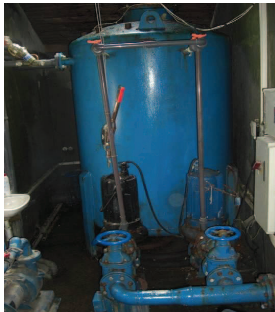
Obr. 53 Vývěvy 2x 7,5 kW
