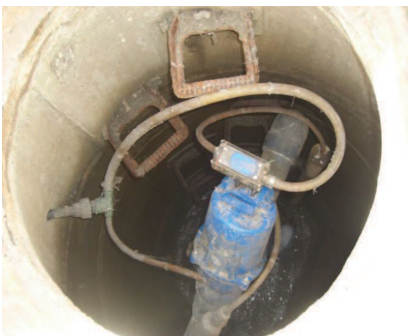
Obr. 48 Ventil v betonové šachtě
