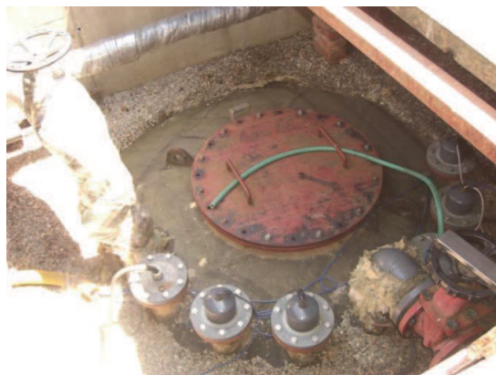
Obr. 62 Podtlaková nádoba
