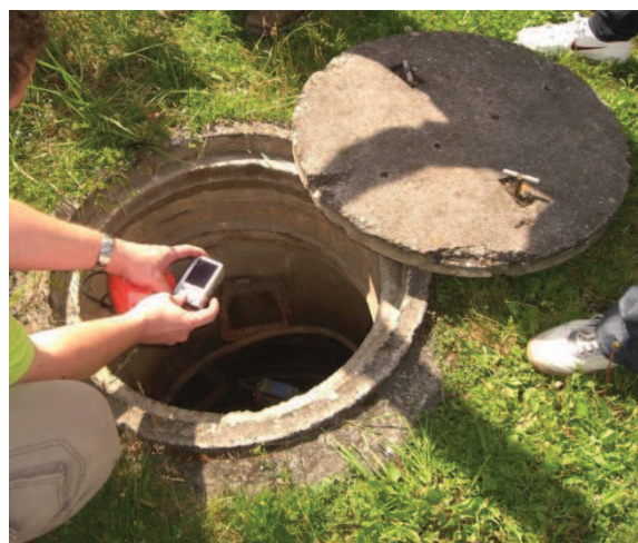
Obr. 49 Betonová šachta s poklopem
