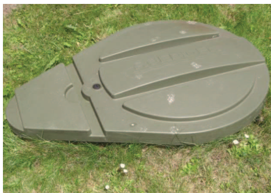
Obr. 70 Poklop sběrné šachty
