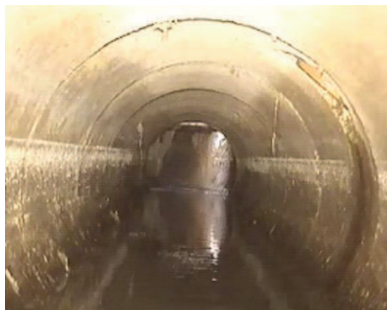
Obr. 24 Netěsnost potrubí
