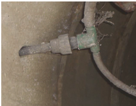
Obr. 50 Napojení hadice na T-kus
