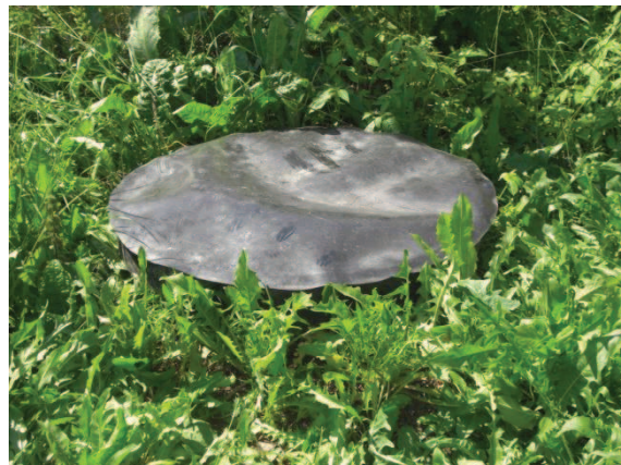
Obr. 80 Poklop betonové šachty
