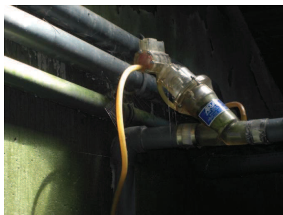
Obr. 55 Dvoucoulový ventil
