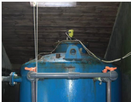
Obr. 57 Ultrazvukem měřený podtlak
