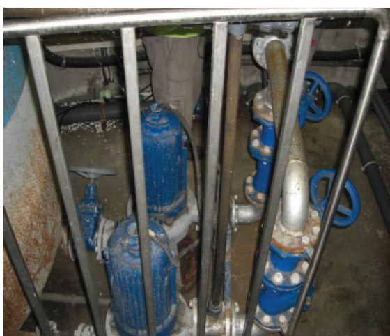
Obr. 39 Vodokružní vývěvy
