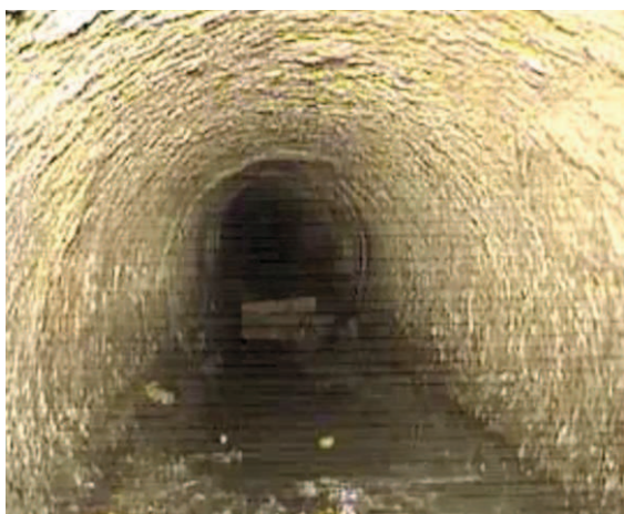
Obr. 25 Koroze stěn
