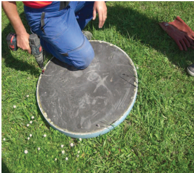
Obr. 16 Plastová šachta zabezpečená šrouby
