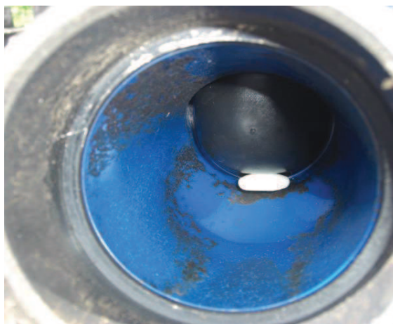
Obr. 66 Ventil s uzavřenou membránou
