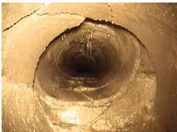
Obr. 21 Deformace stokové sítě
