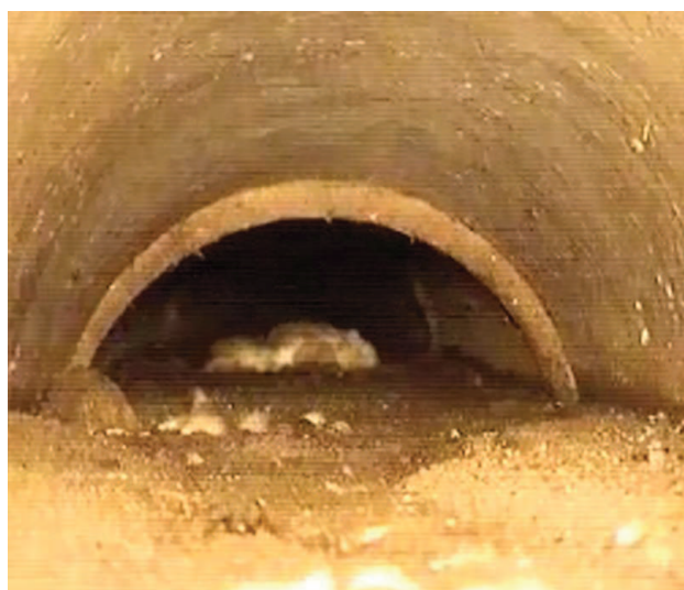
Obr. 28 Zanešené potrubí
