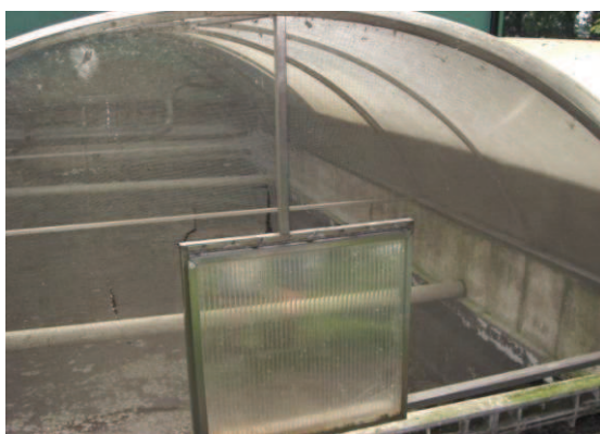
Obr. 33 SBR reaktor
