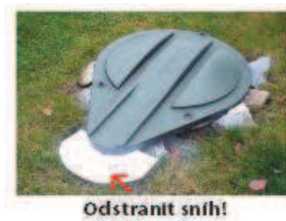
Obr. 18 Poklop sběrné šachty [19]
