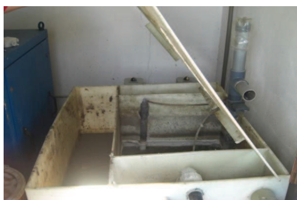
Obr. 32 Mechanické předčištění
