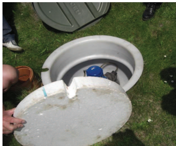
Obr. 64 Tepelná izolace na šachtě
