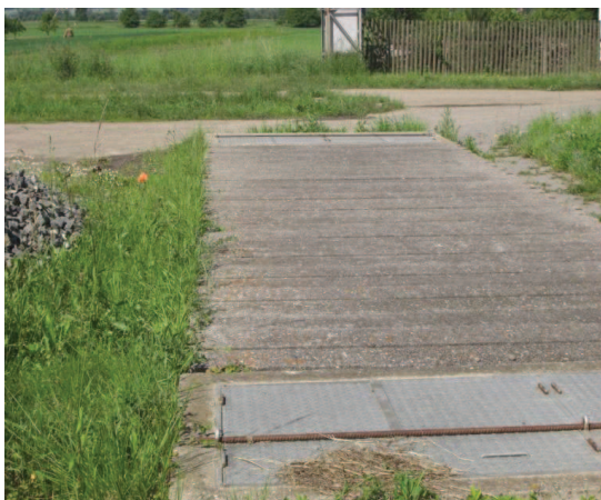
Obr. 17 Třetí stupeň čištění – pískový filtr
