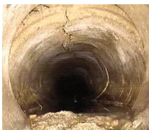
Obr. 84 Nánosy sedimentů
