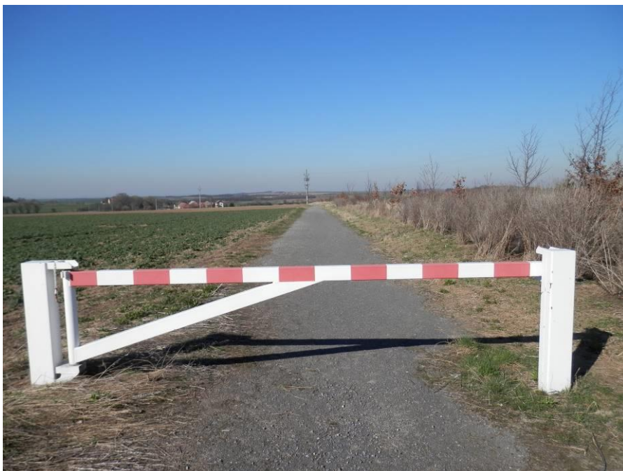
Foto č. 30: C11 je vedlejší polní cesta, která byla navržena k rekonstrukci.
