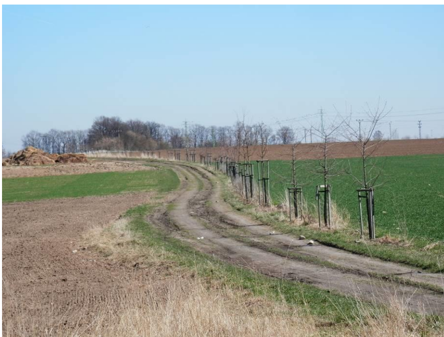
Foto č. 29: C7 je hlavní polní cesta, která byla navržena k rekonstrukci.
