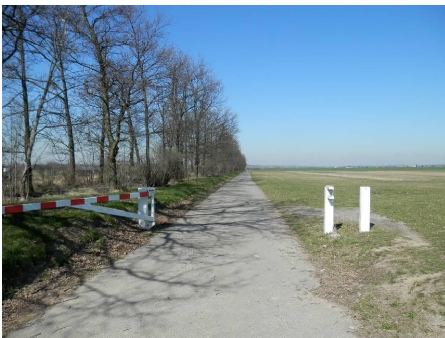
Foto č. 31: NC3 je hlavní polní cesta, která byla navržena k rekonstrukci.
