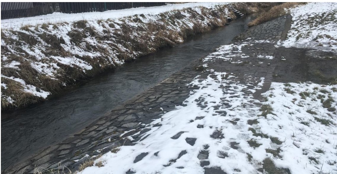
Obr. 6.16 – Opevnění pravého břehu (pohled po proudu)
