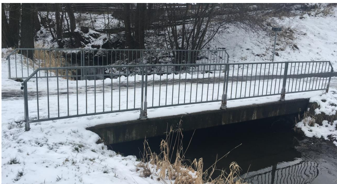
Obr. 6.6 – Betonový most M1 (pohled proti proudu)
