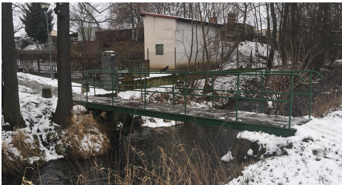
Obr. 6.8 – Ocelová lávka L1 (pohled po proudu)
