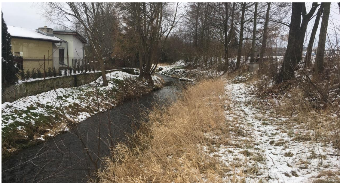
Obr. 6.4 – Opěrná zídka a složený průtočný profil s pravostrannou bermou (pohled po proudu)
