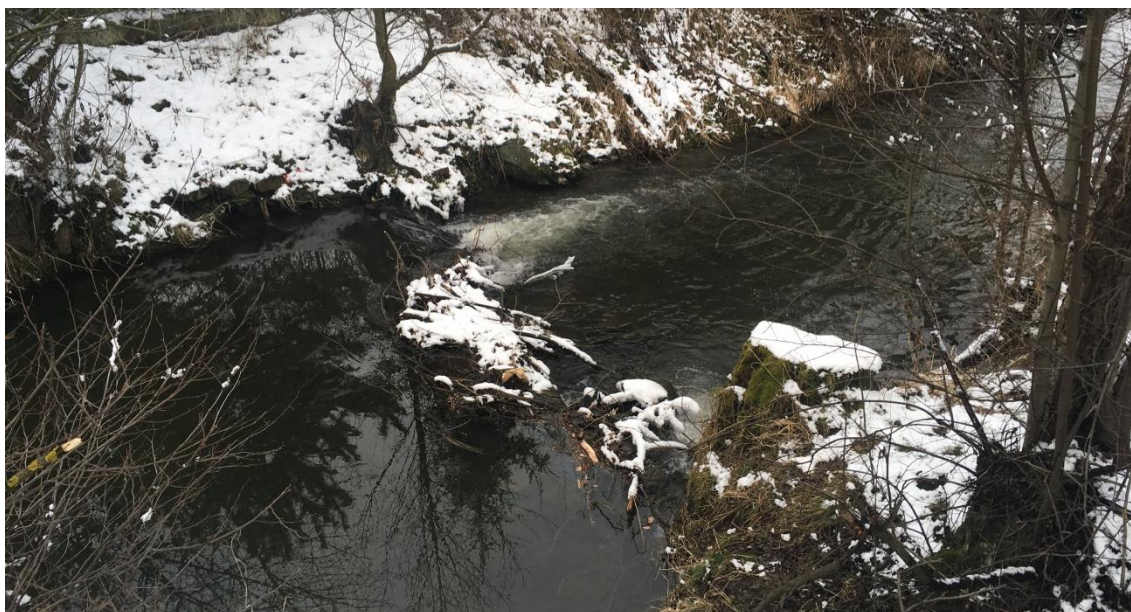
Obr. 6.5 – Spádový stupeň (pohled po proudu)
