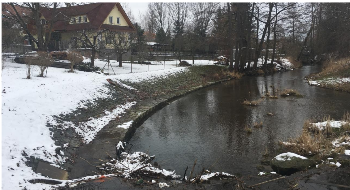
Obr. 6.3 – Opevnění břehu a levostranné bermy (pohled po proudu)
