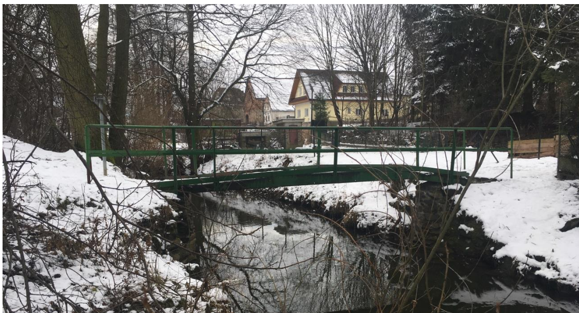
Obr. 6.10 – Ocelová lávka L3 (pohled proti proudu)
