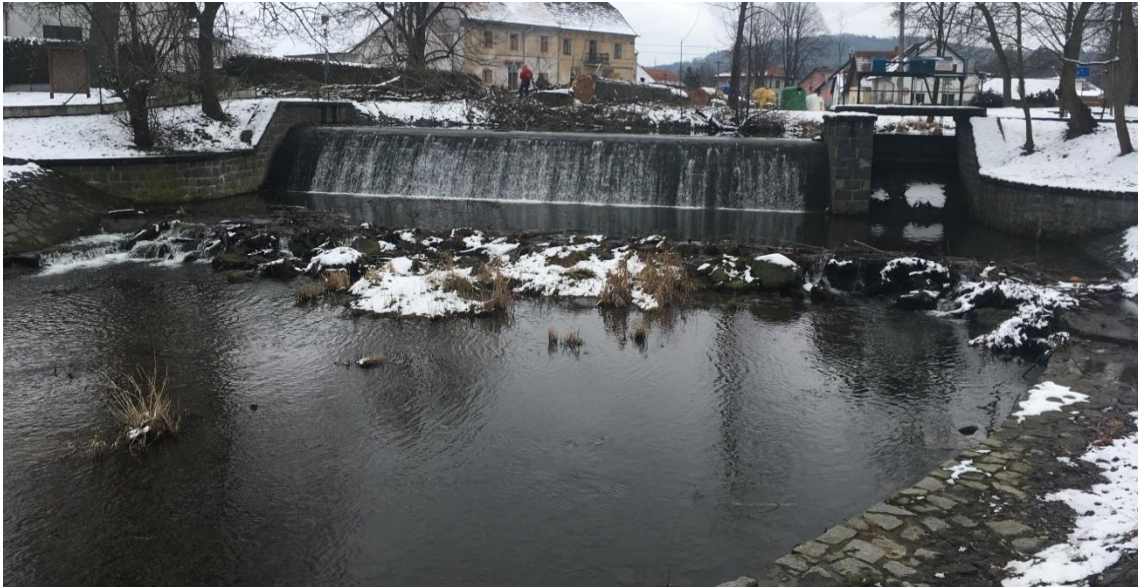
Obr. 6.15 – Celkový pohled na opevnění jezové konstrukce (pohled proti proudu)
