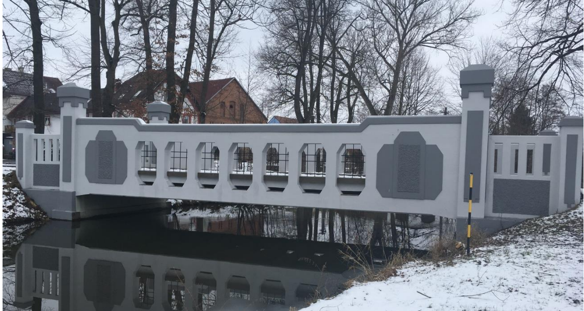
Obr. 6.7 – Silniční most M2 (pohled po proudu)
