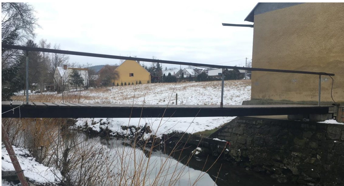
Obr. 6.9 – Dřevěná lávka L2 (pohled proti proudu)
