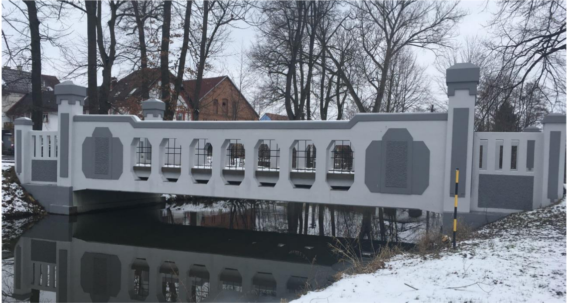
Obr. 6.7 – Silniční most M2 (pohled po proudu)
