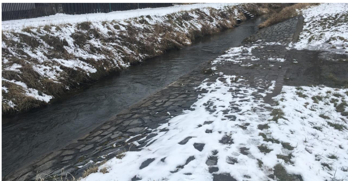
Obr. 6.16 – Opevnění pravého břehu (pohled po proudu)
