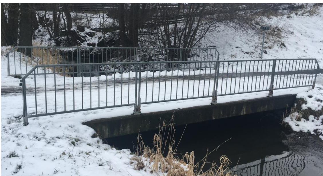
Obr. 6.6 – Betonový most M1 (pohled proti proudu)
