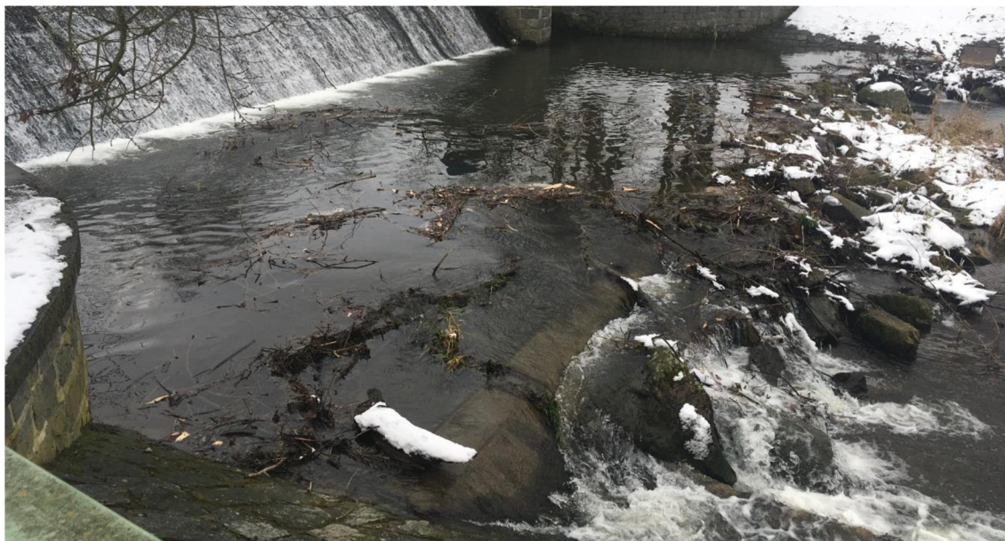
Obr. 6.2 – Zanesené dno za vývaříštěm
