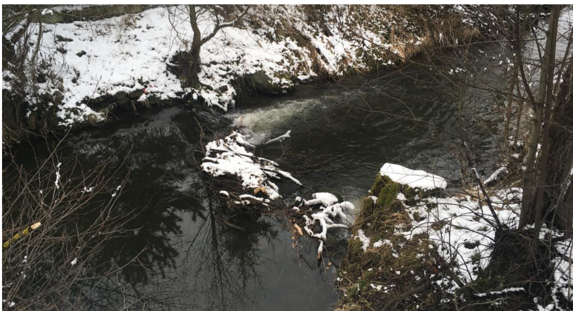
Obr. 6.5 – Spádový stupeň (pohled po proudu)
