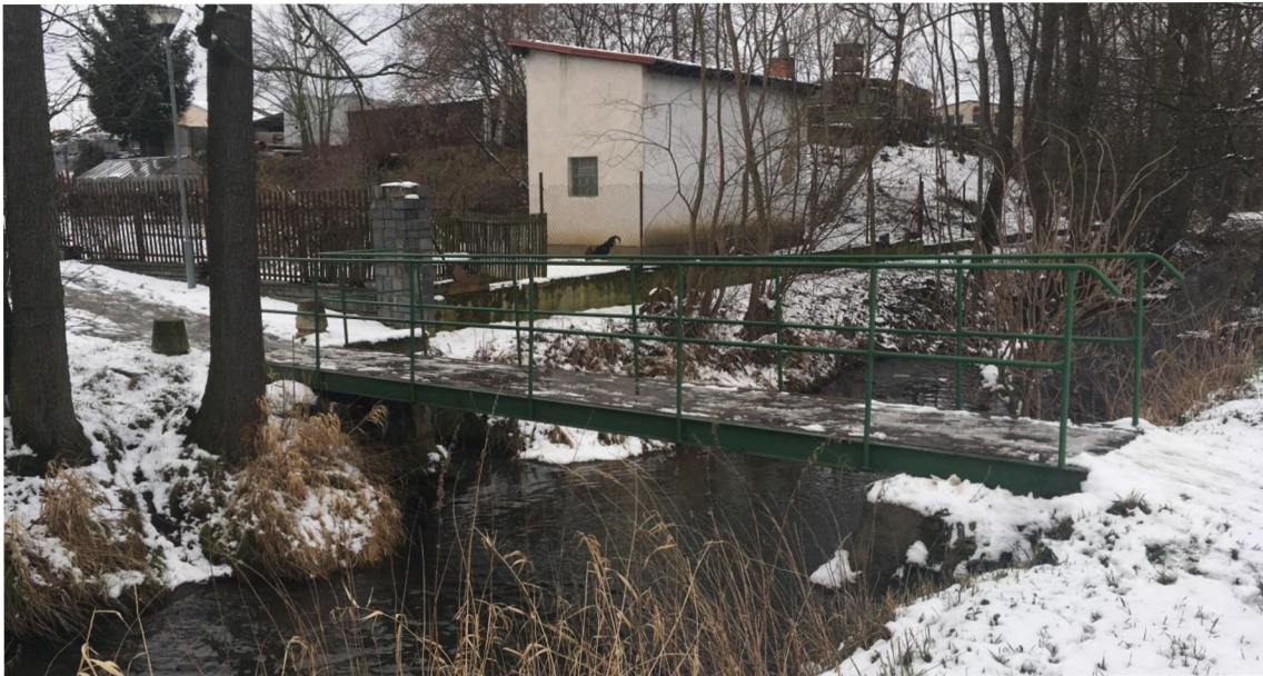
Obr. 6.8 – Ocelová lávka L1 (pohled po proudu)
