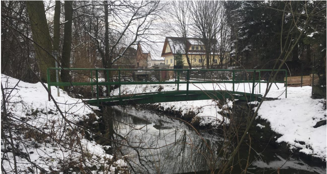
Obr. 6.10 – Ocelová lávka L3 (pohled proti proudu)
