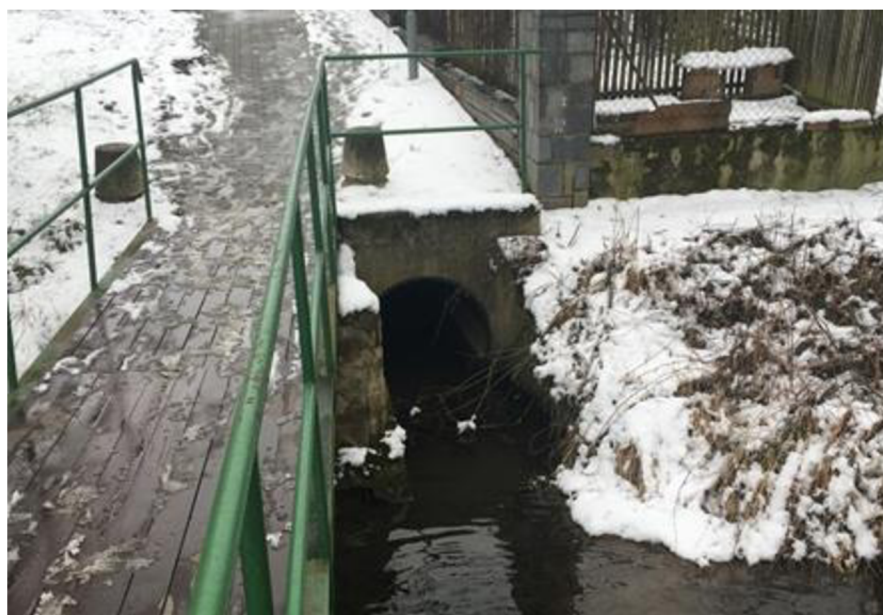
Obr. 6.13 – Kanalizační výúst
