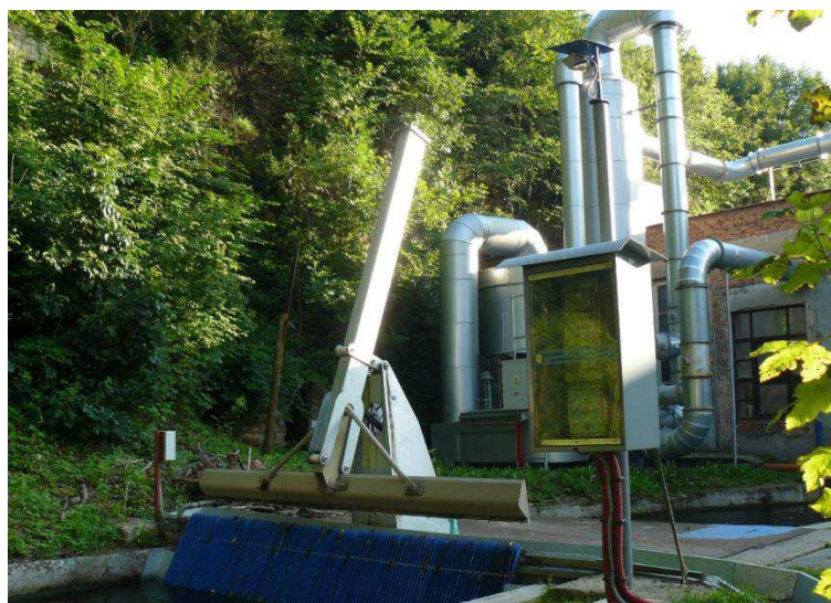
Obrázek č.9 Výsuvné shrabovací zařízení firmy Gyrus [12]
