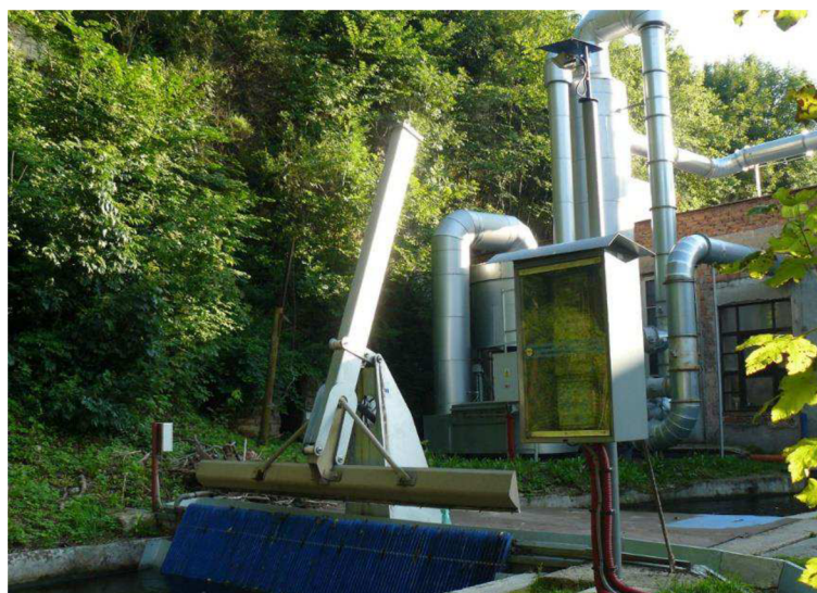
Obrázek č.9 Výsuvné shrabovací zařízení firmy GyruS [12]
