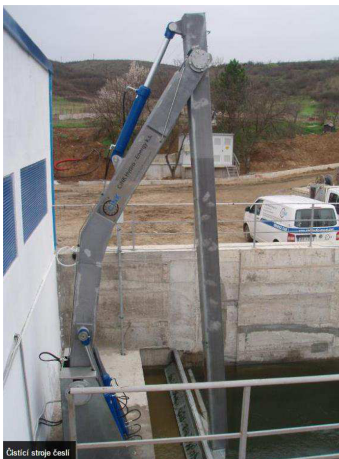
Obrázek č.6 Čistící česle firmy CINK Hydro - Energy k.s [9]
