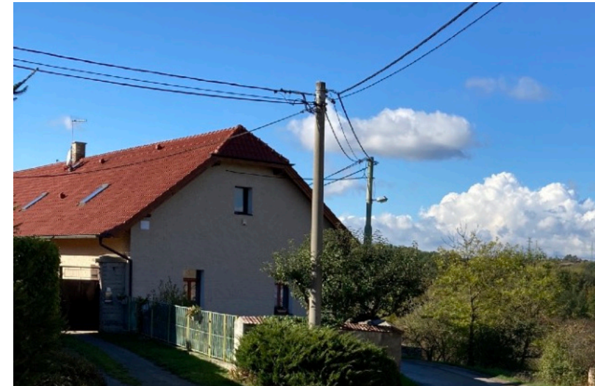
Obr. č. 18: Vedení nízkého napětí v obci zajišťují sloupy (foto: autor)
