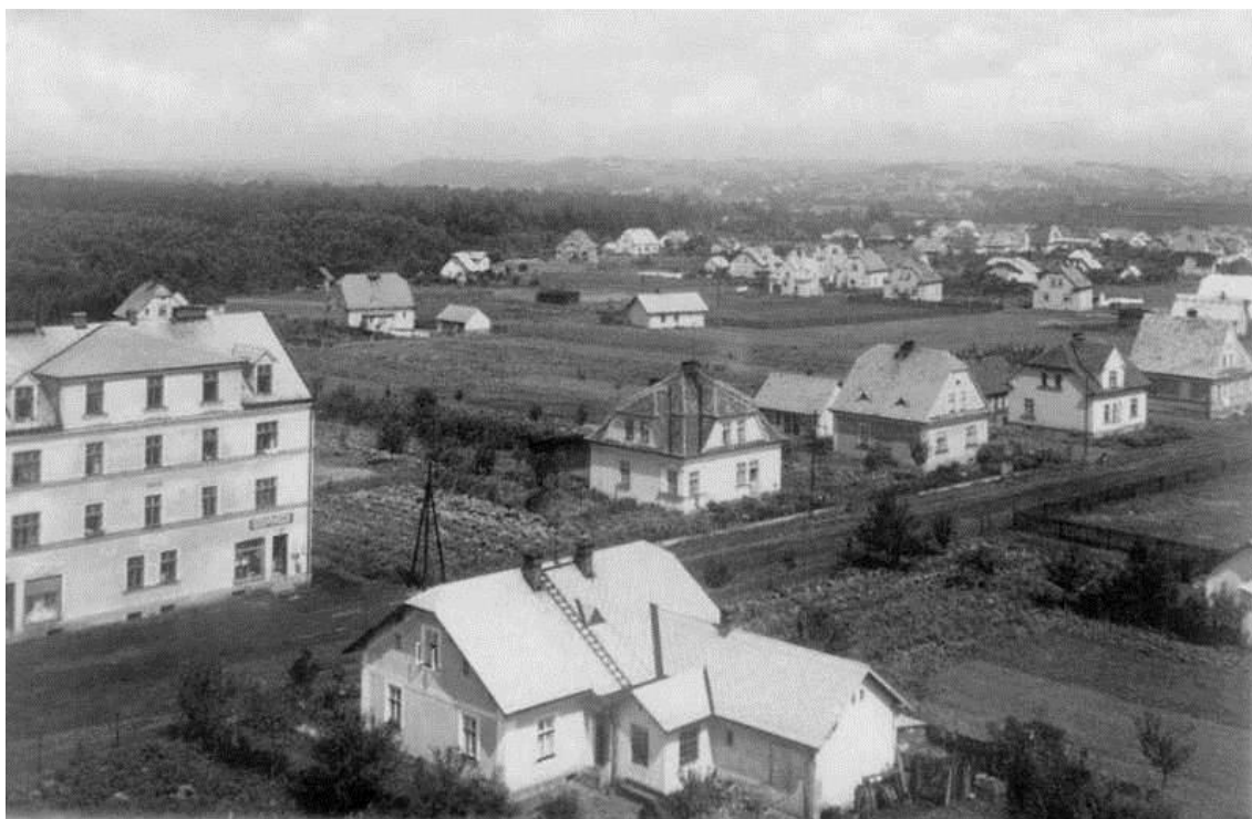
Obr. 3 Kanada - pohled z vodárenské věže na novou hlavní výstavbu v letech 1924-1929, kde bylo postaveno 150 nových domů, rok 1927 (zdroj: Wawrzeczka 1997)
