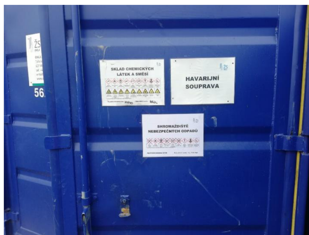
Obrázek 57 Označení skladu s CHLS, nádobou pro NO a havarijní soupravou
