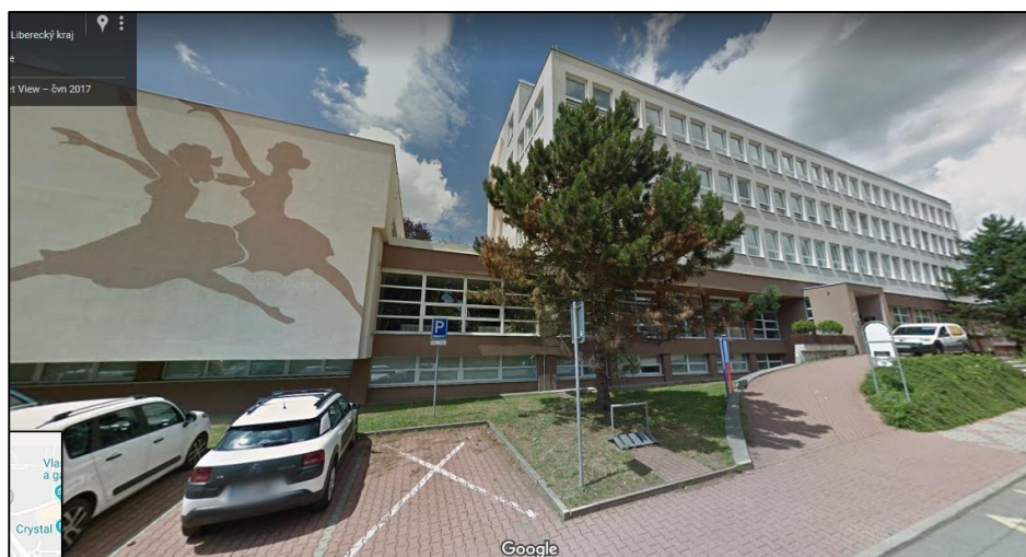
Obr. 15: Bývalý OV KSC v České Lípě po rekonstrukci
