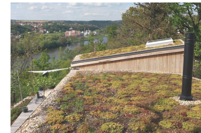
OBR. Č. 35 EXTENZIVNÍ ZELENÁ STŘECHA, zdroj: greenville.cz
