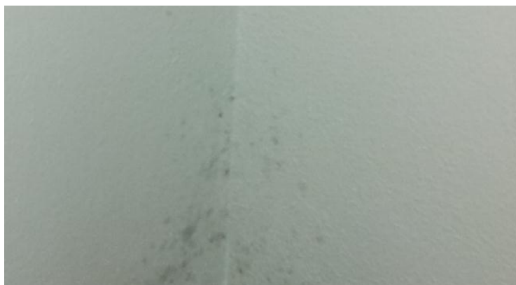
Obr. 16 – Rozvoj plísň bez známek povrchové kondenzace
