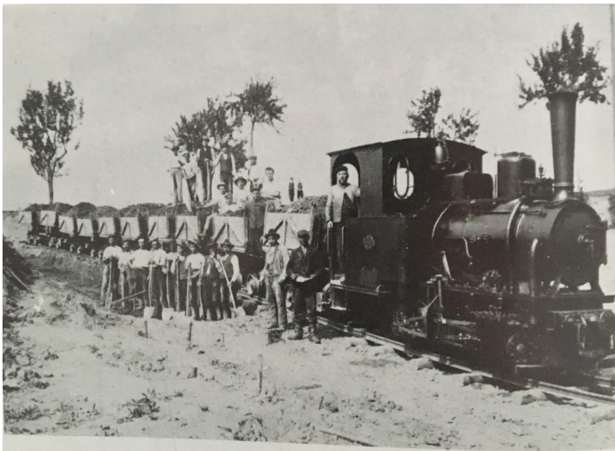
Stavba tratě ve Mříči.
