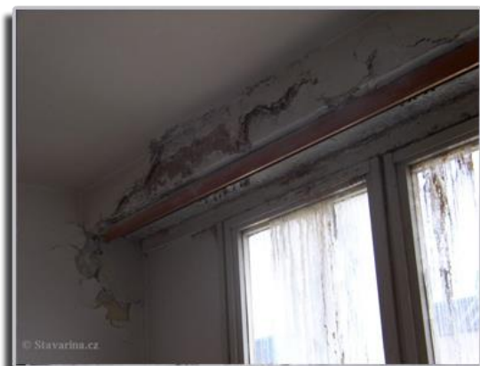
Obr. č. 3 – Důsledky zatékání do konstrukce [12]
