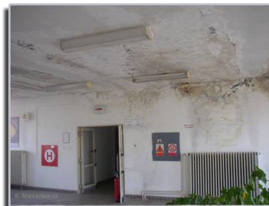
Důsledky zatékání
