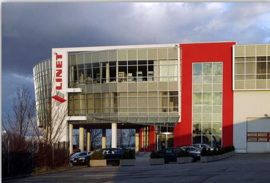
Obrázek č. 10 Hlavní budova společnosti LINET
