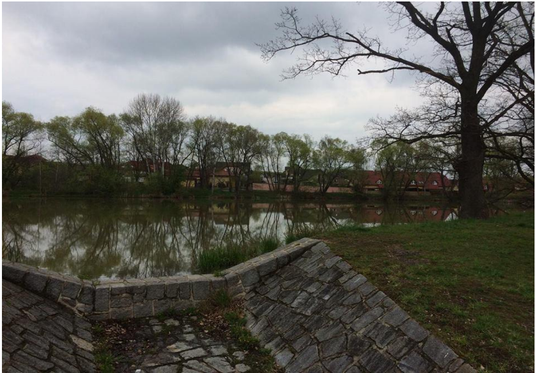
Obr. č.9 – Hráz Dolního Litvínovického rybníka
