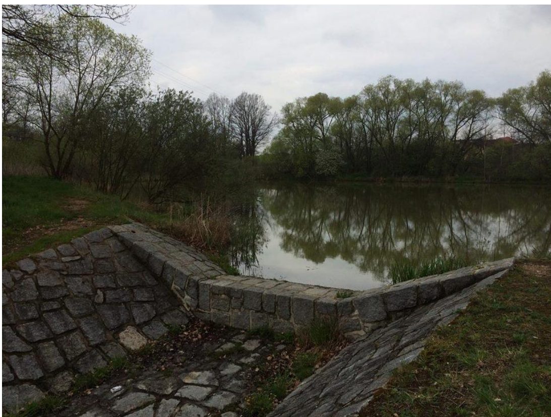
Obr. č.8 – Hráz Dolního Litvínovického rybníka
