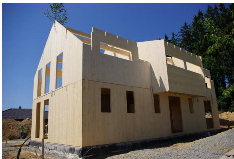
Obr. 10 – Konstrukce z masivního dřeva
