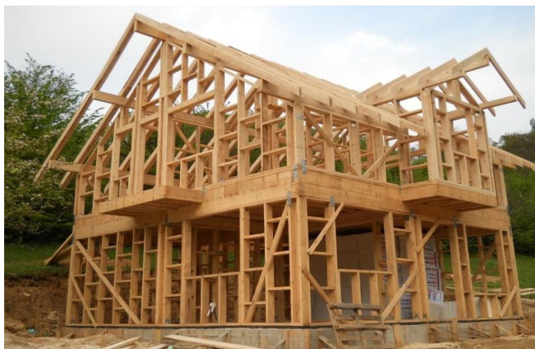
Obr. 7 – Baloon-Frame konstrukce
