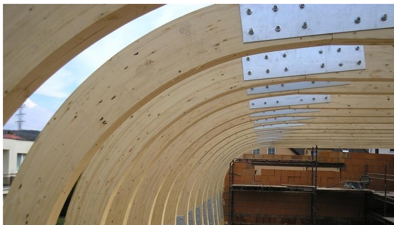
Obr. 4 – Lepená lamelová konstrukce
