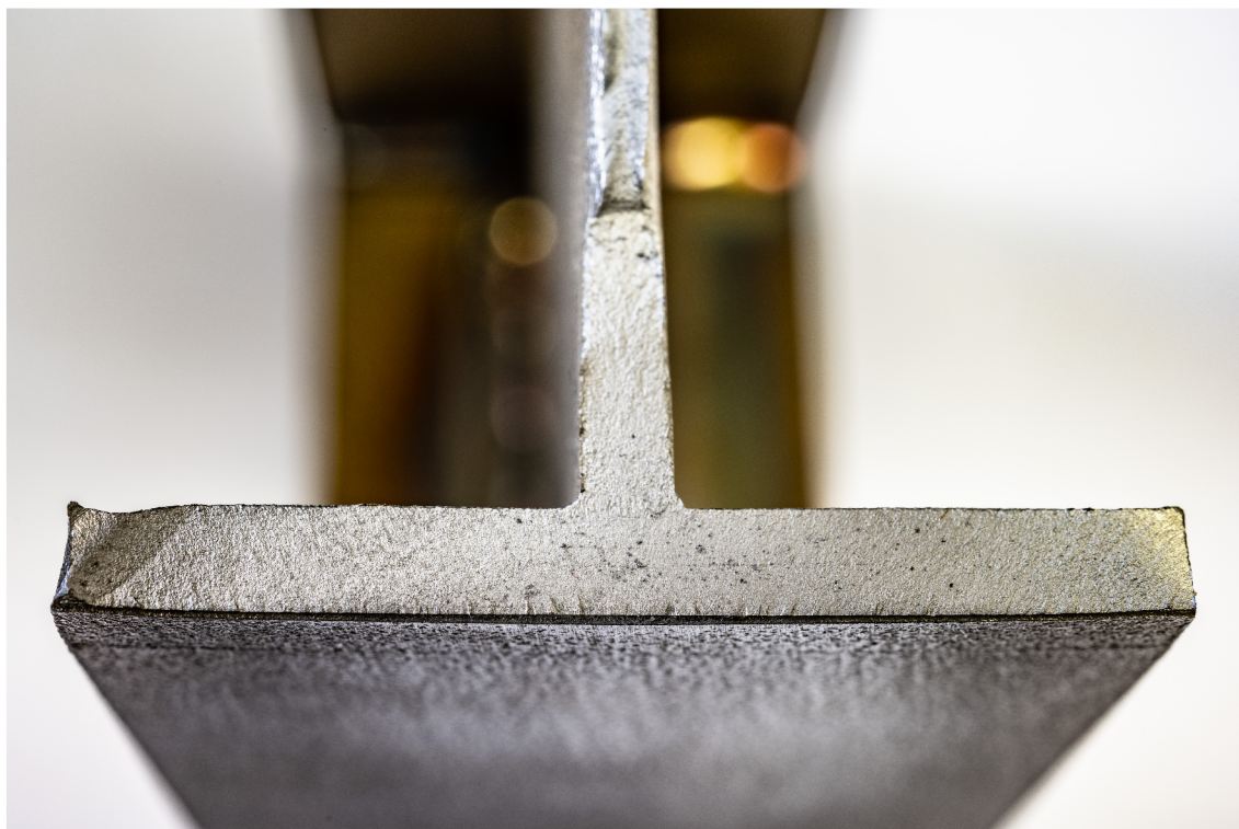
Obr. 2.45: Detail nosníku v místě porušení trhlinou
