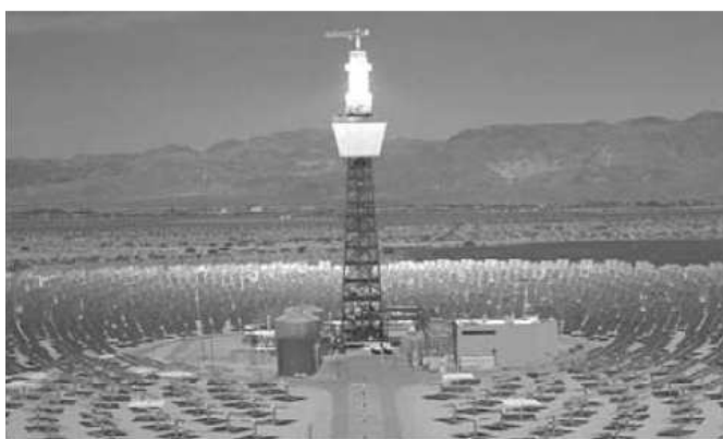
Obr. 2.17 Solární elektrárna využívající tepelnou energii [35]
