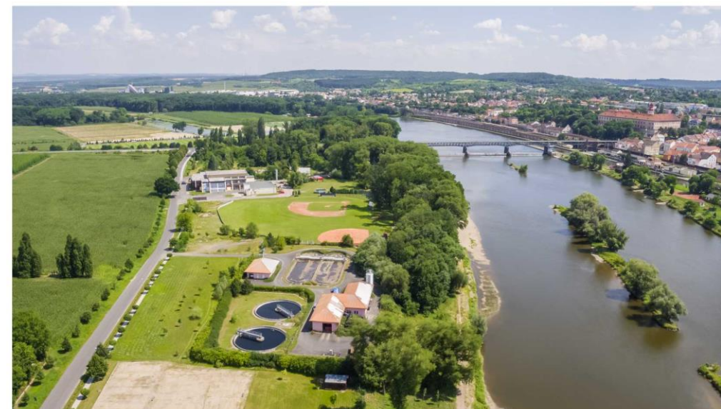
Obr. 84 Čistírna odpadních vod Vědomice
