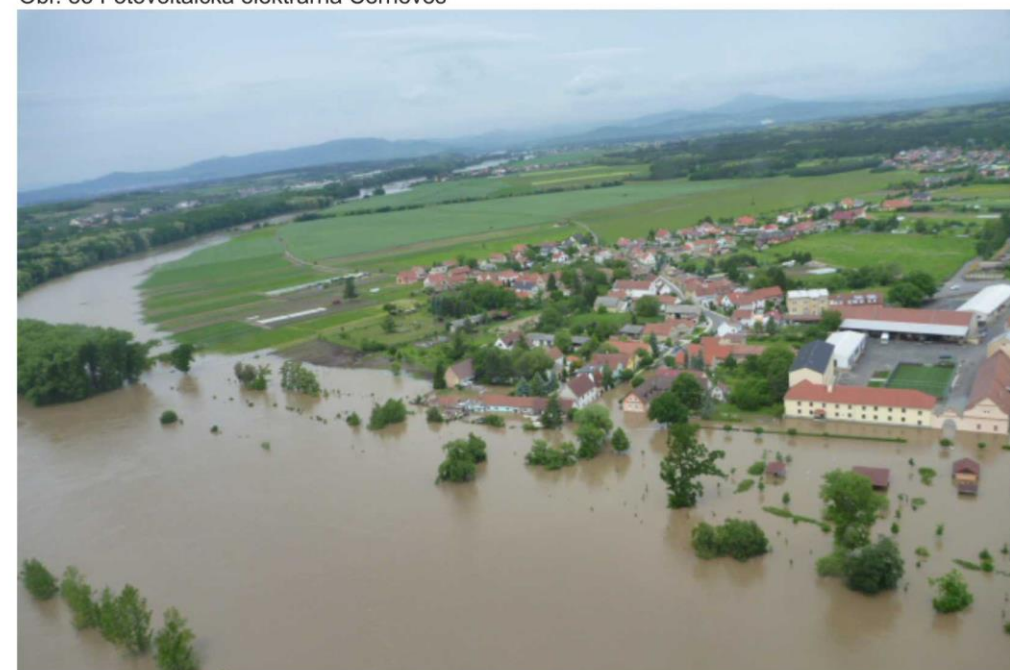
Obr. 86 Povodně 2013 (zaplavená část Staré Vědomice)
