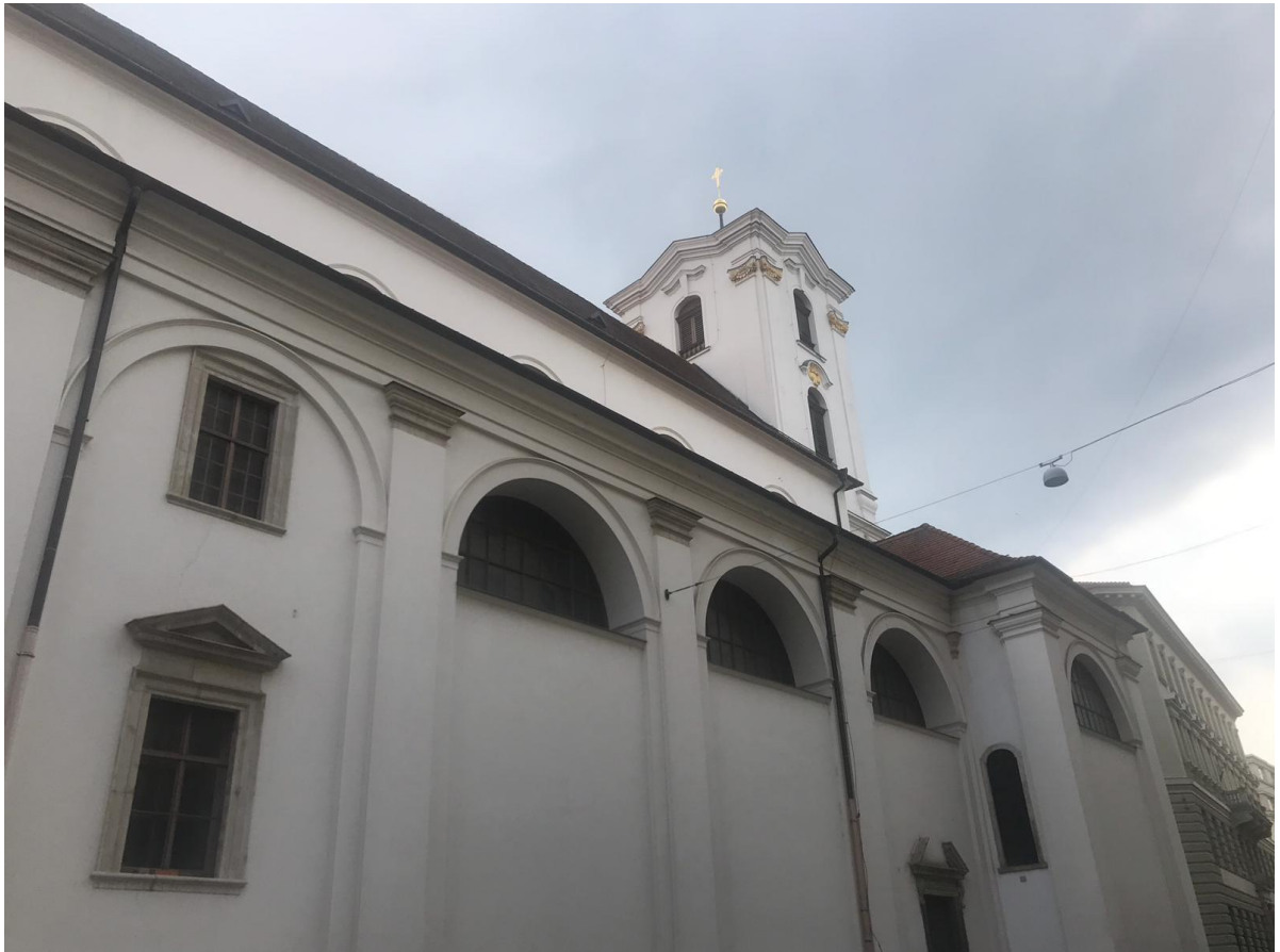
74. Brno, kostel Nanebevzetí Panny Marie, 1598–1602, severní boční fasáda.
