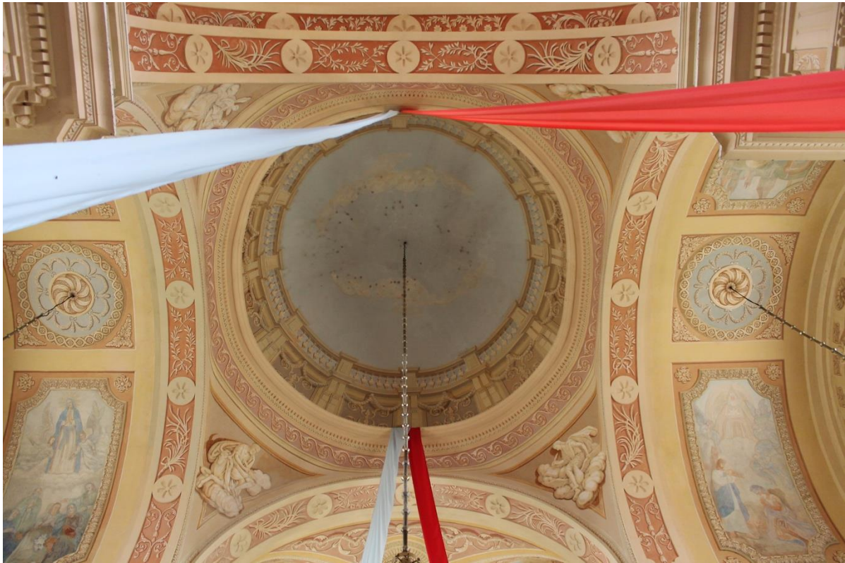
66. Lučaj, kostel sv. Judy Tadeáše, 1766–1777, pohled do kupole.
