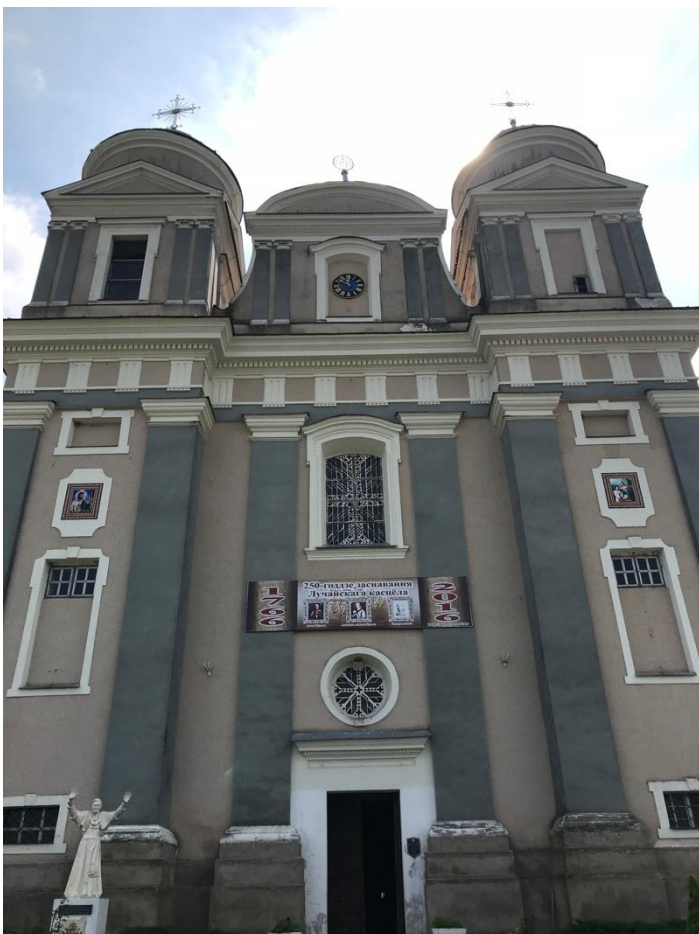
60. Lučaj, kostel sv. Judy Tadeáše, 1766–1777, hlavní dvouvěžové průčelí.
