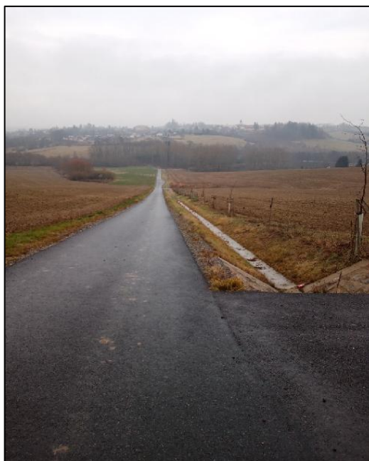
Obrázek 69 - Polní cesta VPC 24 s výhybnou, doprovodnou zelení a protierozním příkopem (Zoufalý, 2020)
