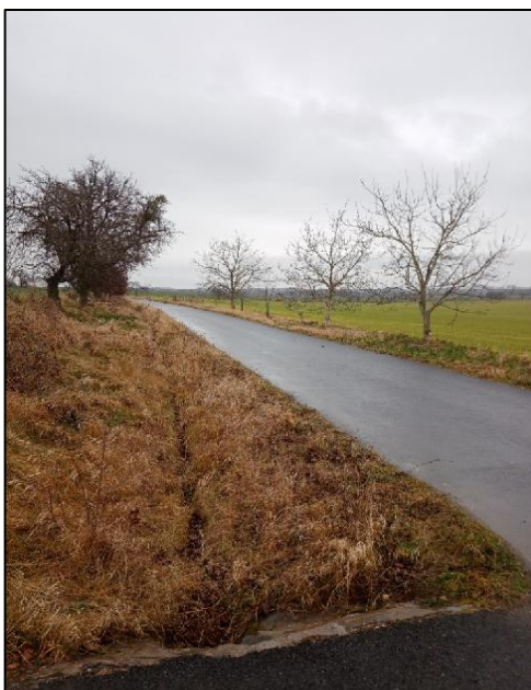
Obrázek 19 – Polní cesta HPC 5 s protierozním příkopem a doprovodnou zelení (Zoufalý, 2020)
