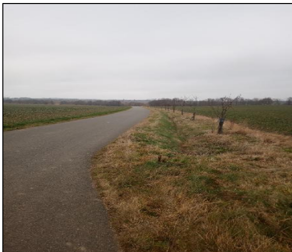
Obrázek 37 - Polní cesta HPC 2 s protierozním příkopem a doprovodnou zelení (Zoufalý, 2020)
