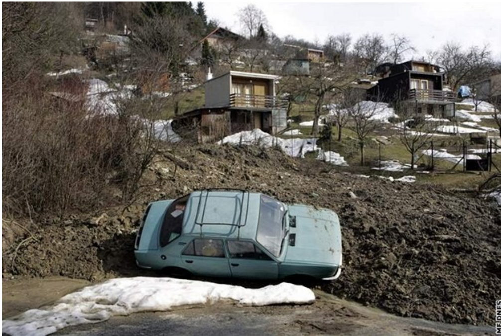
Obrázek 4: Sesunutý svah na komunikaci
