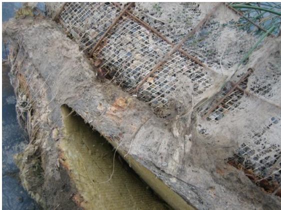
Obr. č. 13.1.7 Zima 2015, detail filtrační stěny
