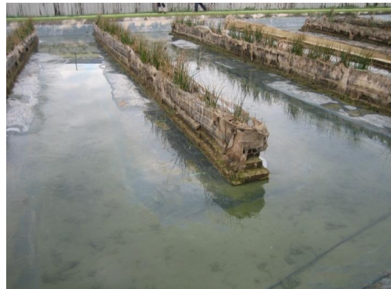
Obr. č. 13.1.8 Zima 2015, filtrační stěna
