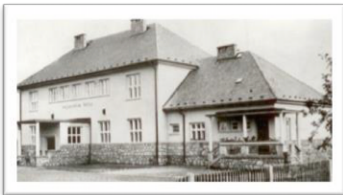
Obr. 9 Budova školy (kronika školy)
