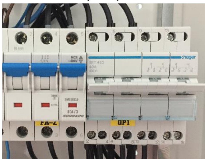
Obrázek 11: Jistič zálohy a skupinový přepínač (pořízeno v laboratoři UEEN)
