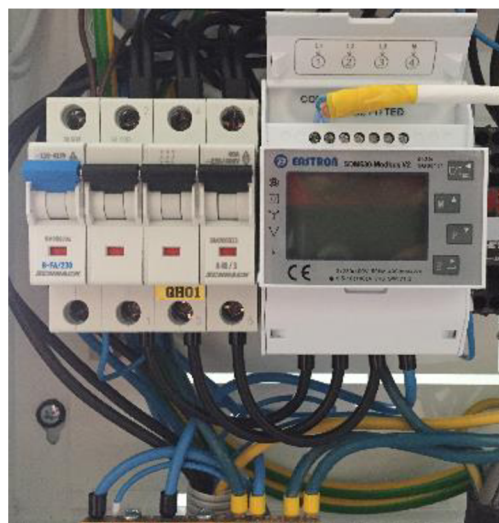
Obrázek 9: Elektroměr a hlavní vypínač (pořízeno v laboratoři UEEN)
