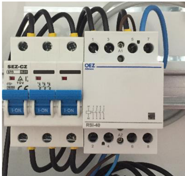
Obrázek 12: Stykač a jeho předřazený jistič (pořízeno v laboratoři UEEN)
