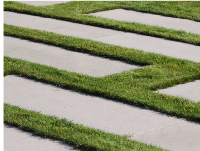
Betonové dlaždice v trávě
