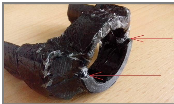
Obr. 6-1 Defekt spôsobený vymývaním vlákna
