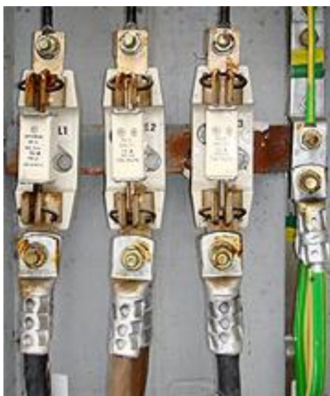
Obr. 5-1 Ukázka pojistkové skříně s nožovými pojistkami (Upraveno podle [12]).
