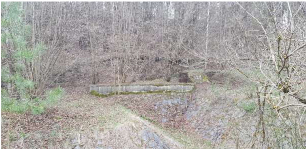
Obr. 16: Protierozní technické opatření v místní části Horní Krupá
