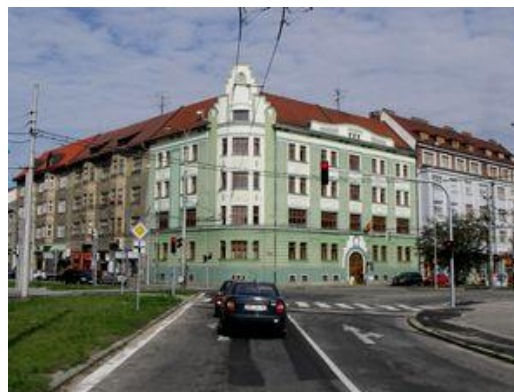
Obrázek č. 4 – budova Magistrátu města, sídlo správního odboru
