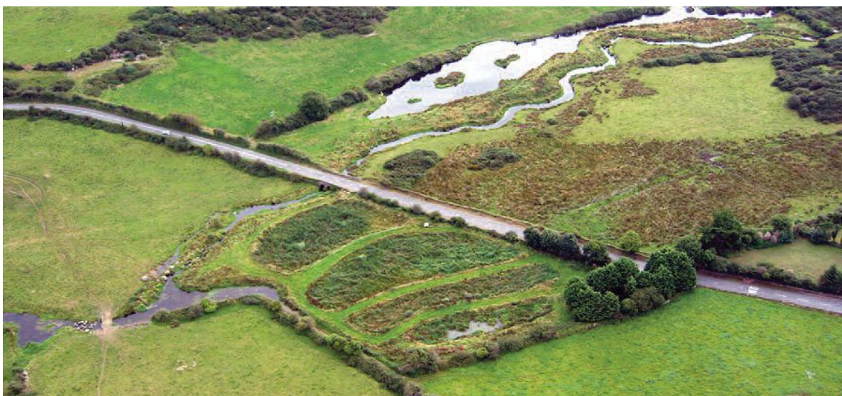
Obr. 3: Letecký pohled na ICW systém kopírující obrysy krajiny v Irsku ( http://www.viron.ie/en [3] ).
