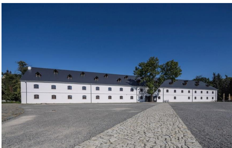
Obr. 11 Budova Olomoucké Pevnosti poznání (zdroj: https://www.pevnostpoznani.cz )
