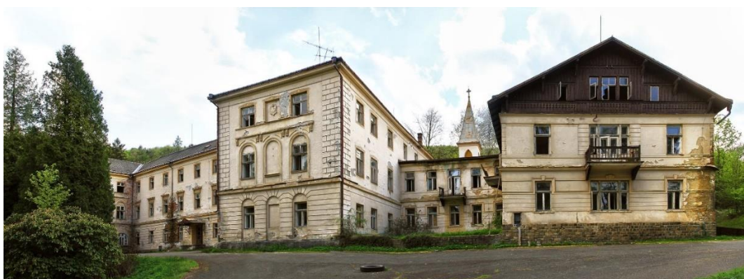
Obr. č. 14: Hlavní budova lázní na břehu řeky Moravice (zdroj: spravnym.smerem.cz)
