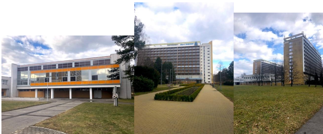
Obr. č. 21, 22, 23: Rehabilitační Sanatorium v Karviné – Hranicích, Svět Vitality, budova A a B (vlastní šetření, 13. 3. 2021)
