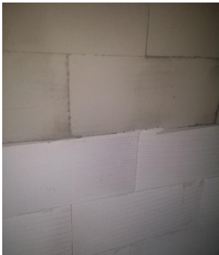
Obr. 24 Dva druhy podkladu – lepidlo Ytong (horní) a pórobeton (dolní)
